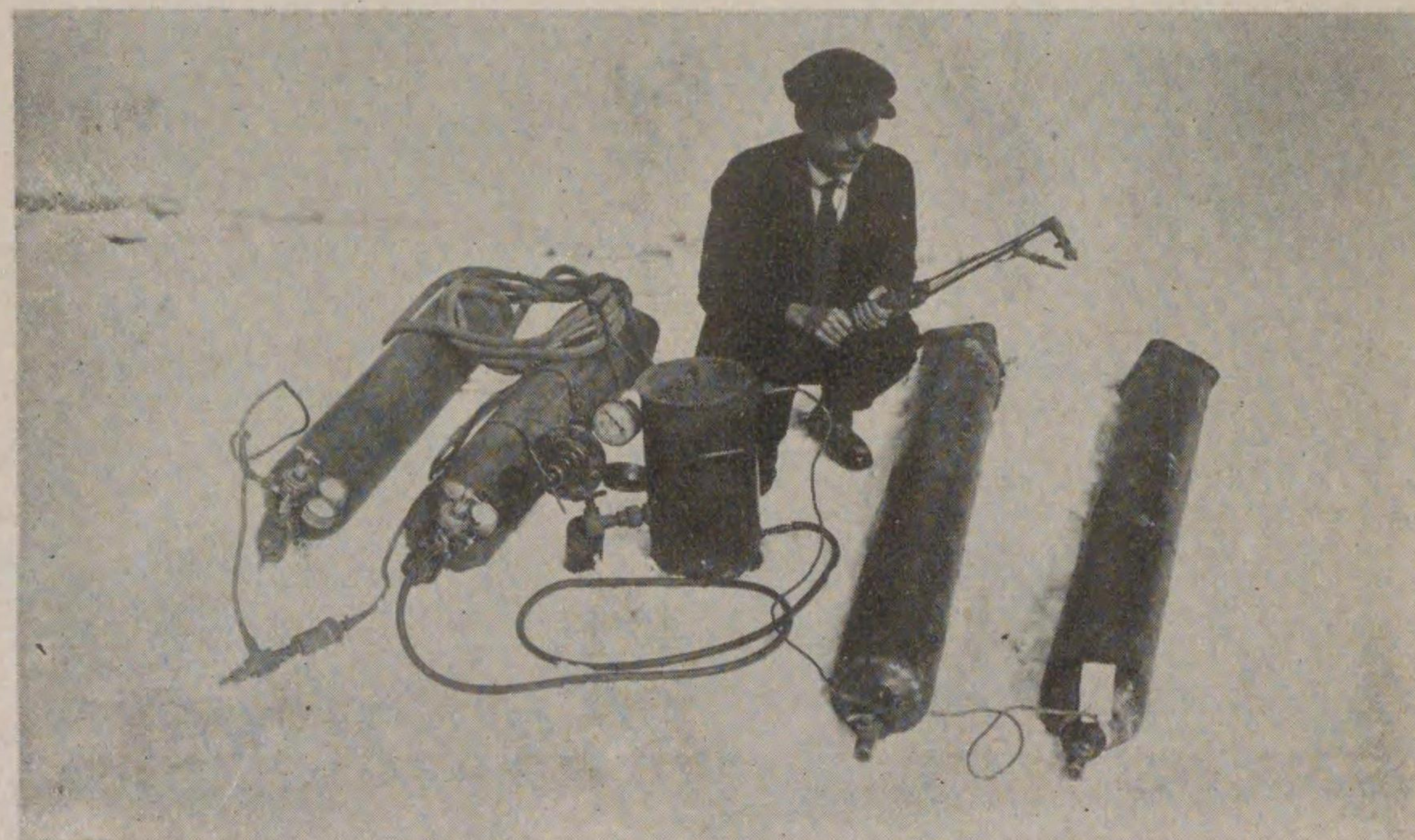
寫眞第7圖 ビカール式水中切斷機
