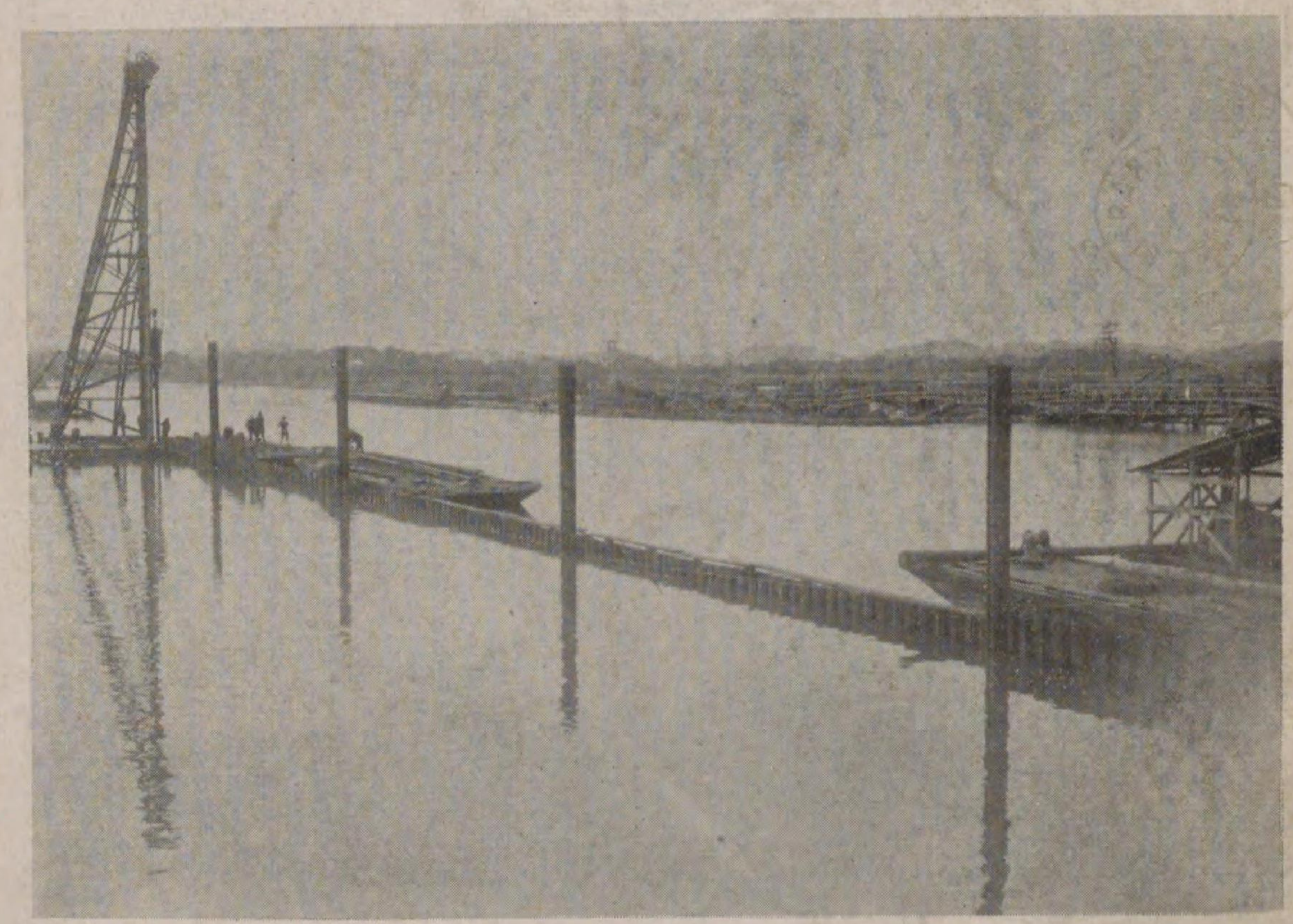
寫真第4圖 式鋼矢板打込
