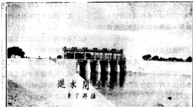
(四)新引河進水閘工程 新引河進水閘，建於北運河東面新引河進口處，專為分洩永定河渾水，使由新引河
