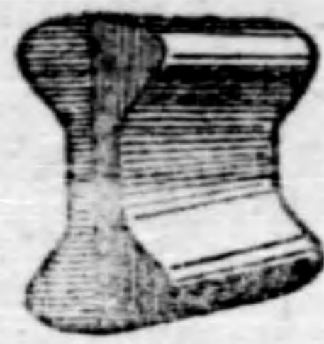
Fig. 24. — Ancien rail symétrique en fer
