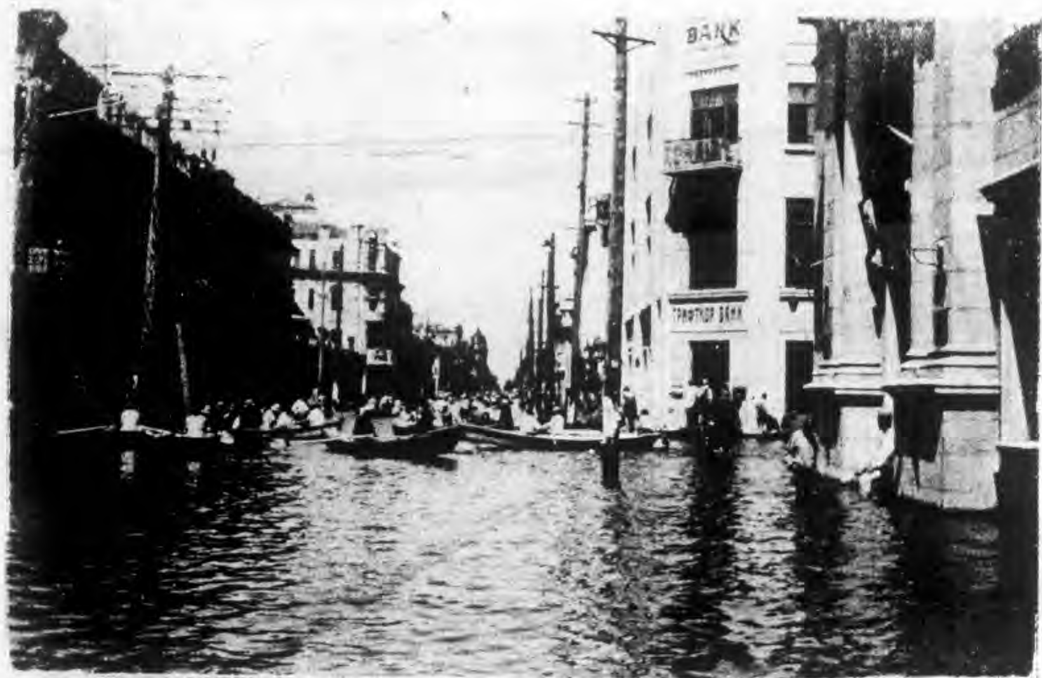
馬惟沒湮被亦漲水次此市街之華繁最裡道係街大央中 頭南街大央中裏道(八) 失損甚無上際實故好良築建大高基地房樓之旁兩路
