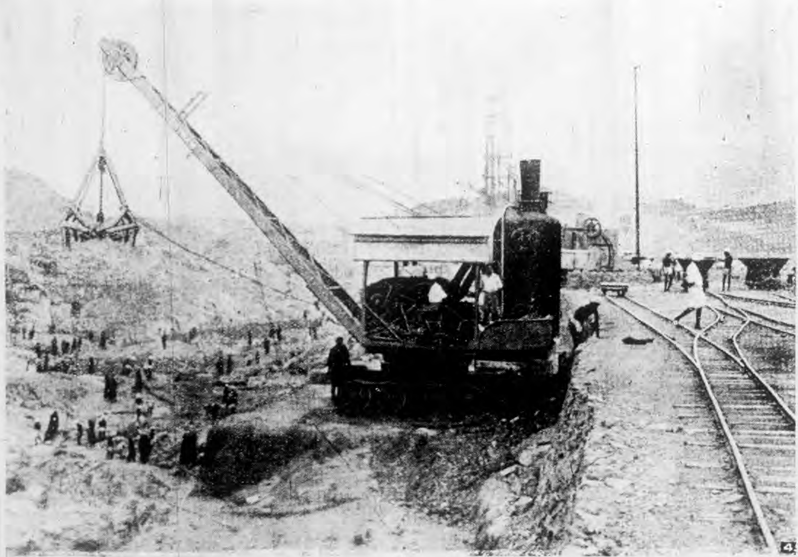
作工之土取事從間鄉度印在機此用利係圖上力之汽蒸用純轉運機該 機土取之廠工曼特斯里普國英(二)
