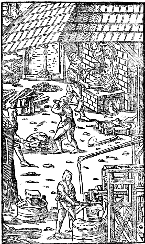
圖十三 阿基柯拉的冶金圖，A. 鎔爐；B. 鐵礦石；C. 鐵渣出口處；D. 鐵塊；E. 木槌、F. 鐵槌；G. 鐵砧。站在爐旁的工人面上有面具蒙着。
