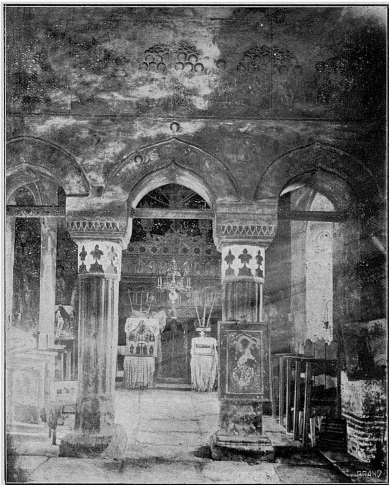
Stâlpii și zidul despărțitor între pronaos și naos.
