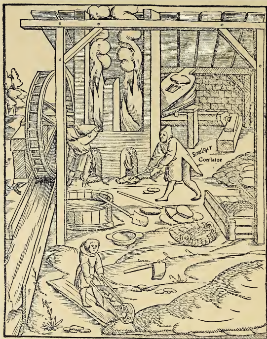
L'ouvroir pour cuire, liquifier, forger et séparer les métaux où la roue poussée par l'eau tourne sans cesse et lève les soufflets qui allument le feu. Le fondeur reçoit continuellement le métal qui est résolu et séparé des pierres métalliques et le jette dedans les seaux. (D'après Seb. Munster.)
