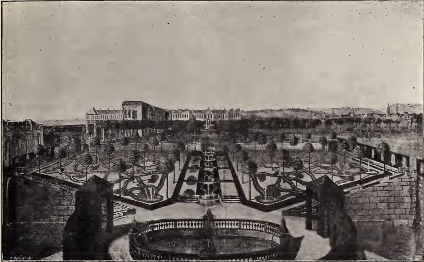
Salle à manger. Orangerie. Château de Palencé. Communs. Cliche Libert.
