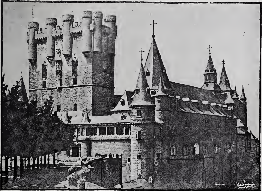
VISTA DEL ALCÁZAR ANTES DE SU INCENDIO
