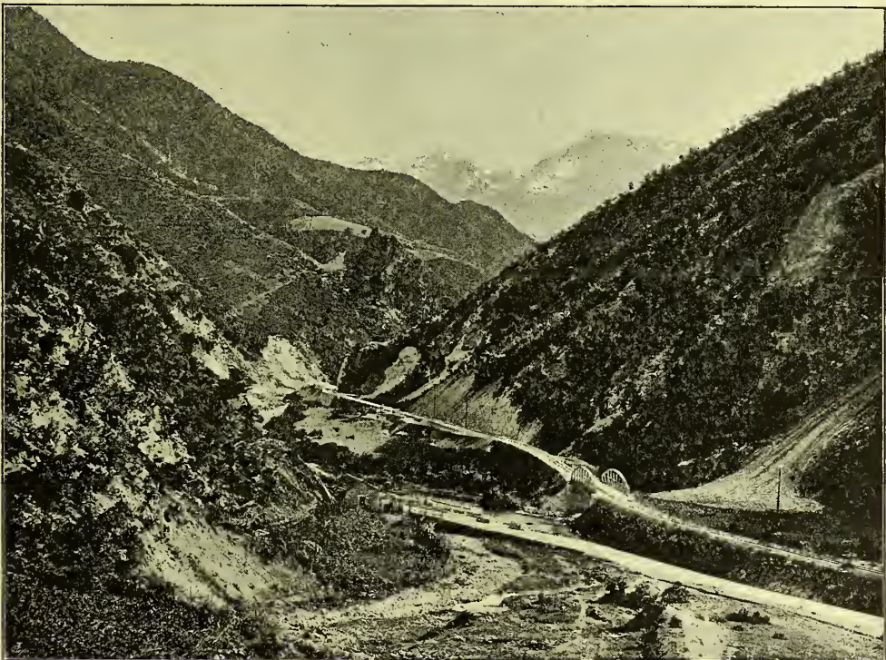
Eisenbahnbrücke über die Trešanica.
