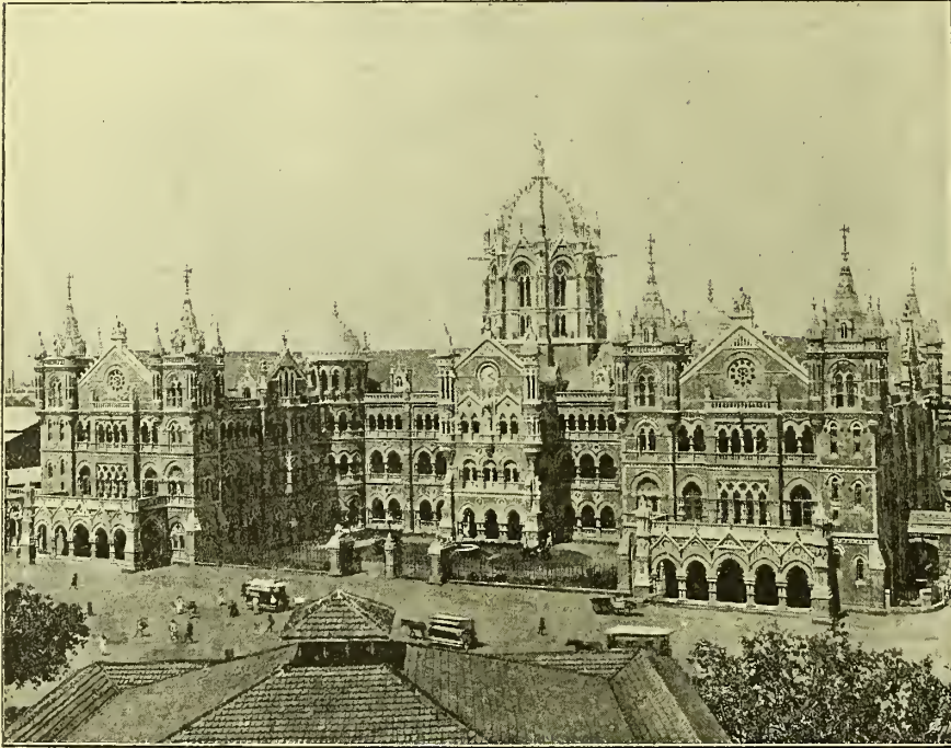
Central-Bahnhof Victoria der Peninsular-Eisenbahn in Bombay.
