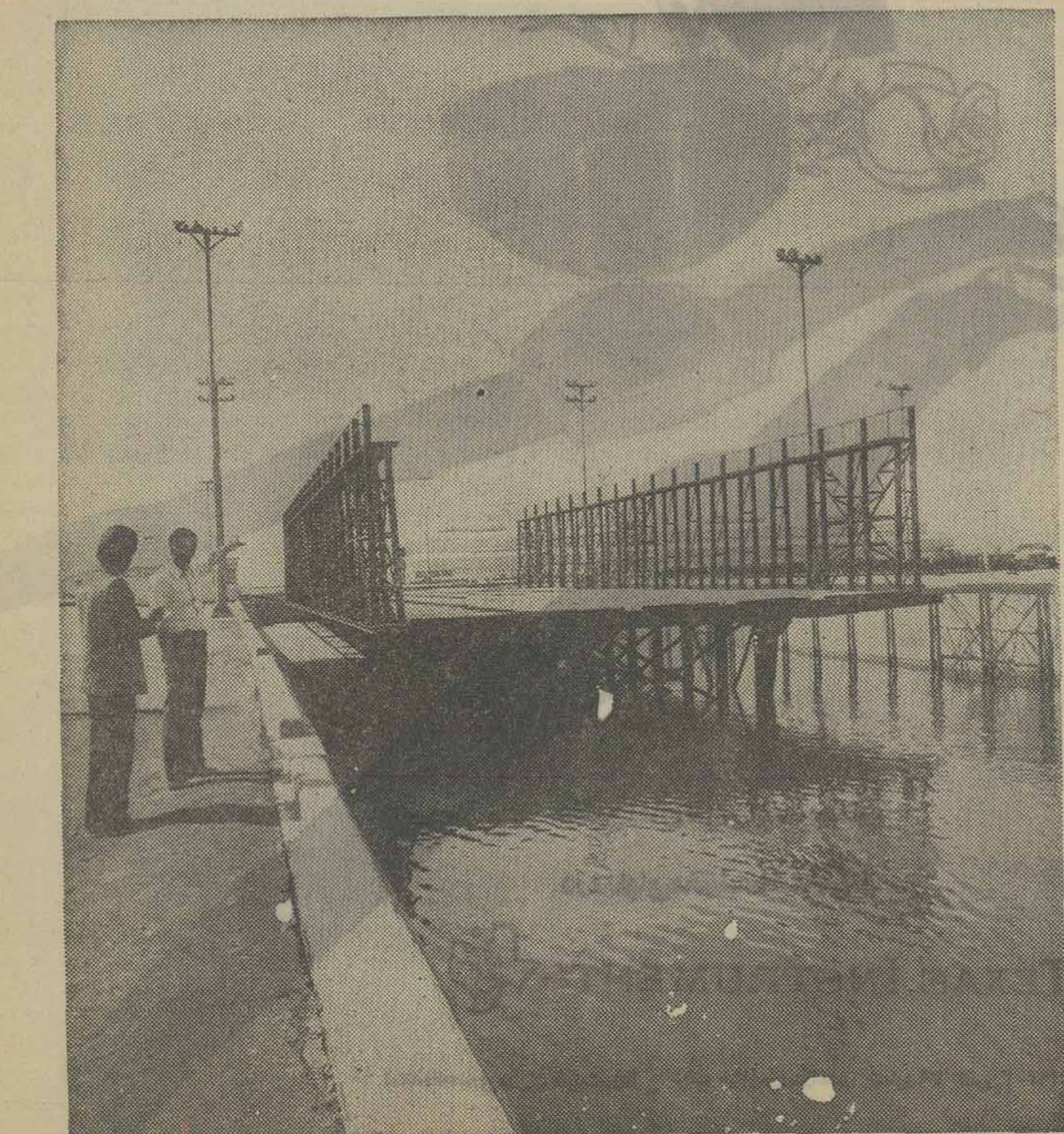
گهواره ، جهت به آب انداختن و یا بالا کشیدن کشتی از طریق سرسره
