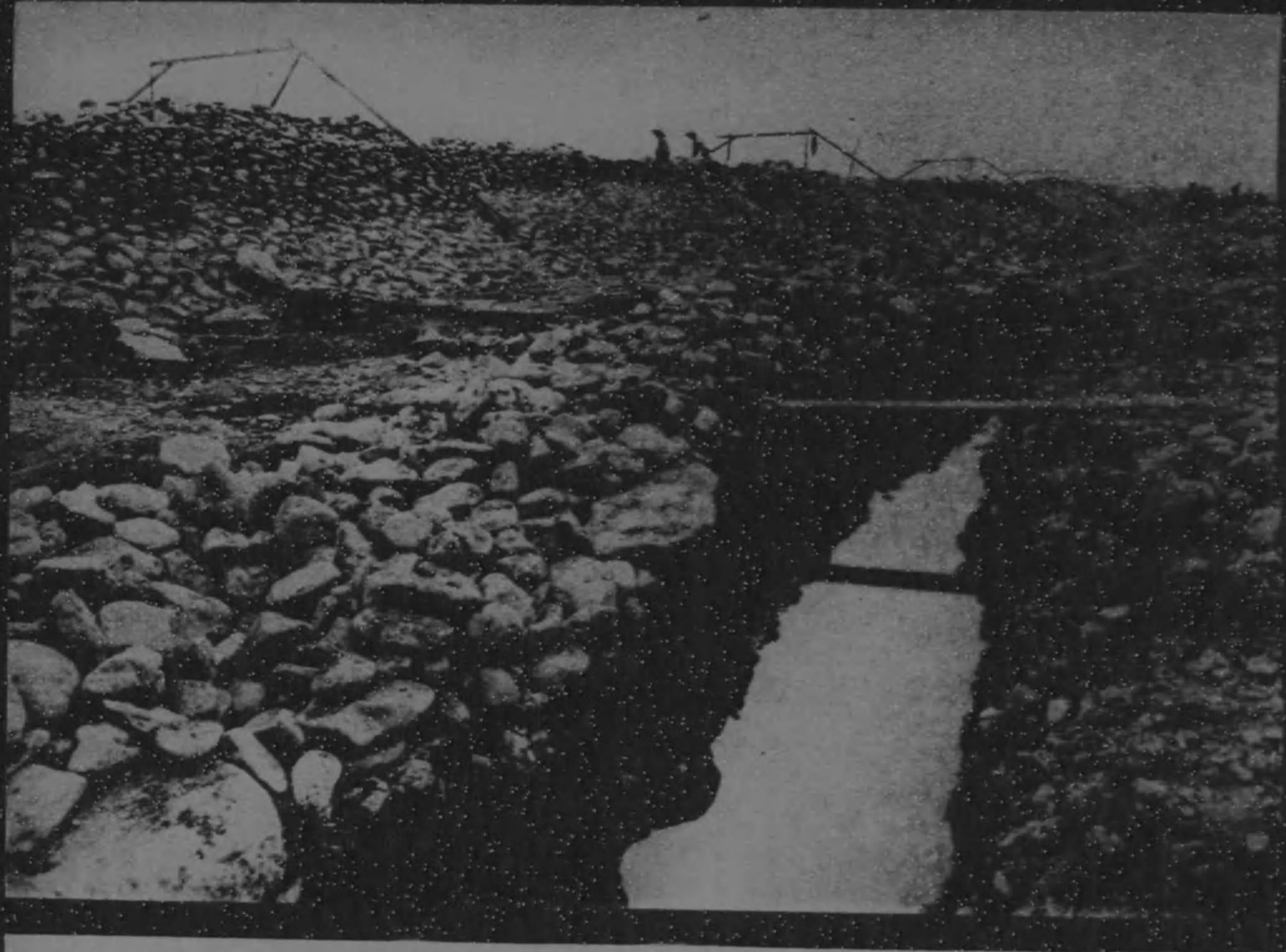
上圖は南澳の干拓工事 下圖は崙背の水利施設
