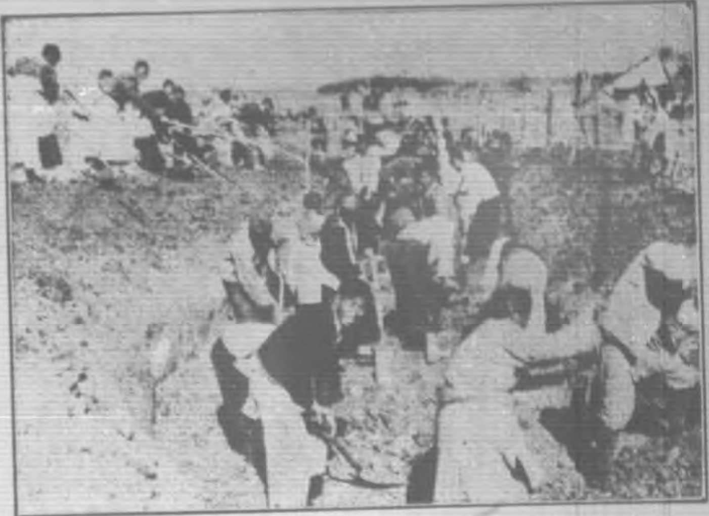
民衆助九路軍掘壕
