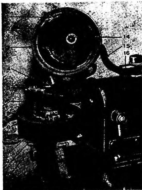
第五十圖 雷曼蓄電池發火裝置
