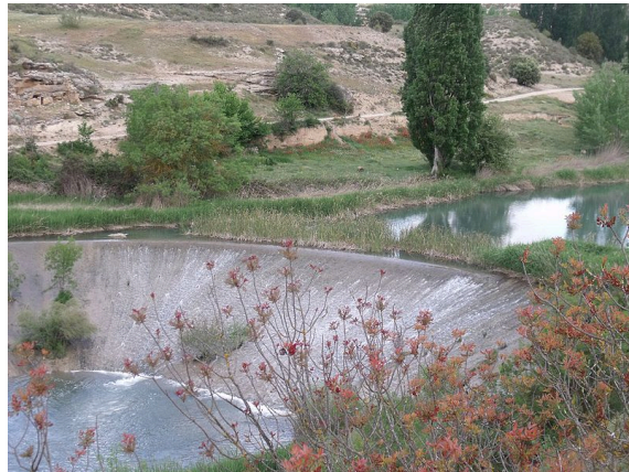
Presa de Moranchel. En este punto no hay cobertura de móvil. Y se acaba el asfalto.
