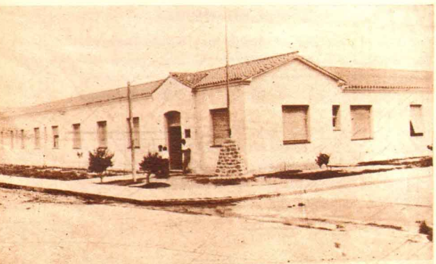
Edificio de la Asistencia Pública, construído en la ciudad de Catamarca con un costo de $ 319.628,82.
