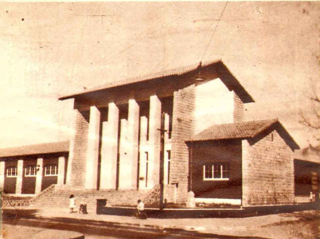
Para la ampliación y el perfeccionamiento de las industrias regionales fué construída esta moderna Fábrica de Cerámica en Catamarca.
