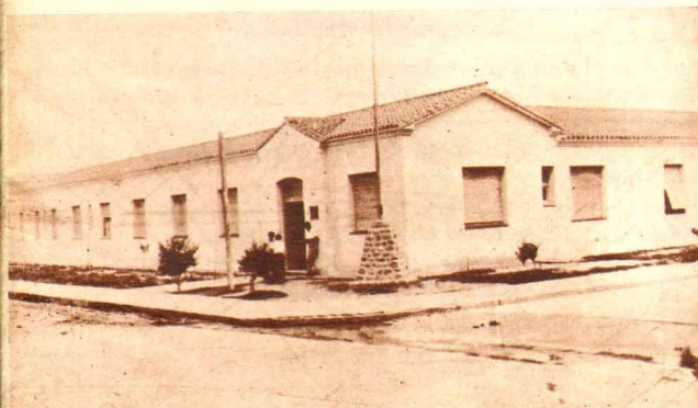
Edificio de la Asistencia Pública, construído en la ciudad de Catamarca con un costo de $ 319.628,82.
