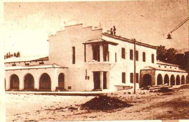
Uno de los mercados construidos por Perón en Catamarca. Este se encuentra en el departamento de Andalgalá y costó $ 151.512,96.
