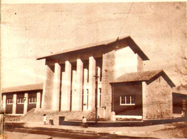
Para la ampliación y el perfeccionamiento de las industrias regionales fué construída esta moderna Fábrica de Cerámica en Catamarca.
