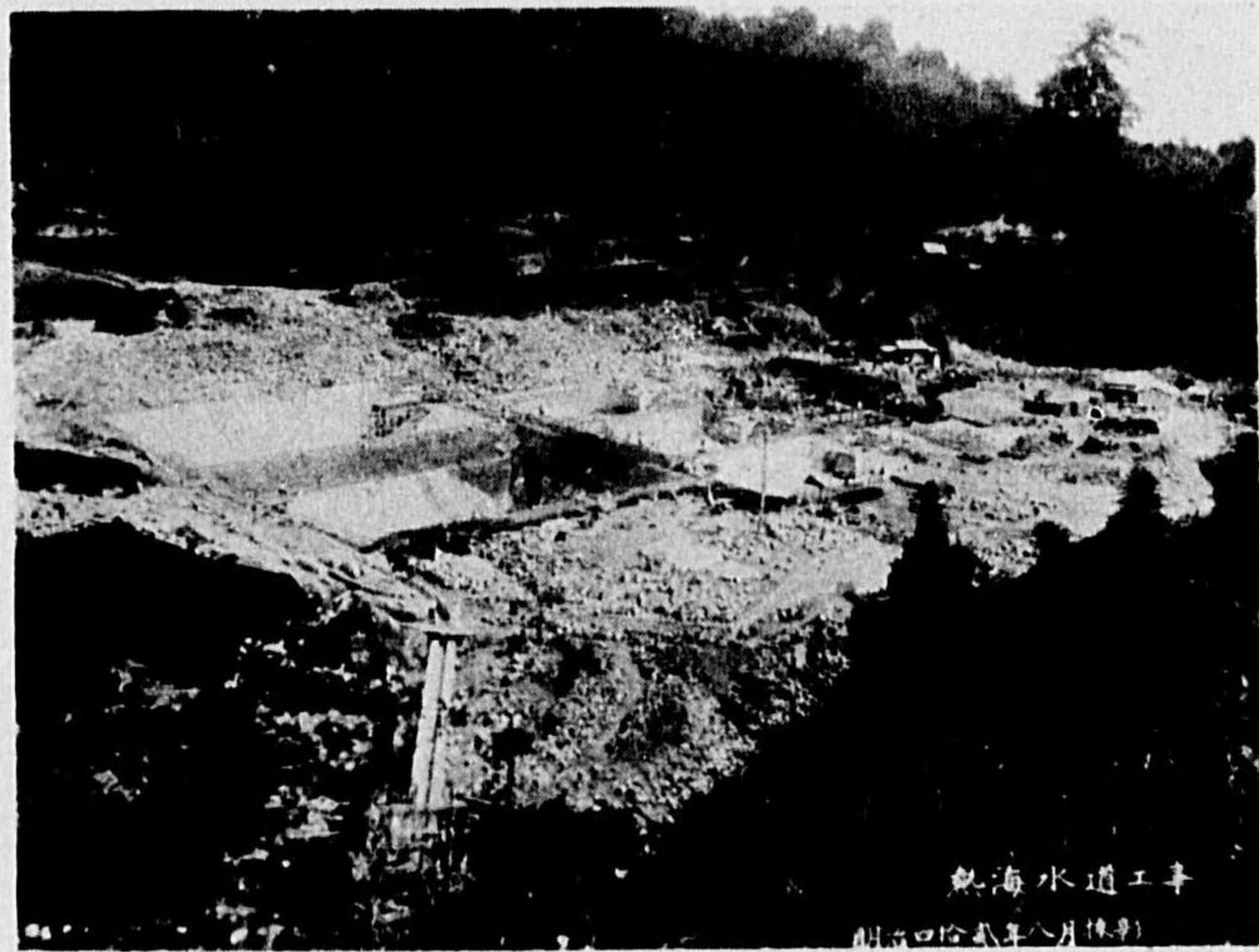
工事中の浄水場
