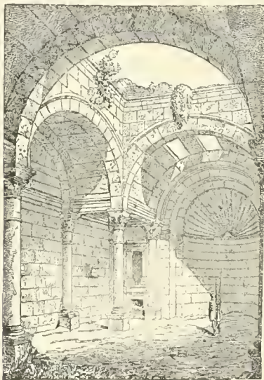
Prétoire de Mousmieh. — Vue intérieure, d'après A. CORROVER.
