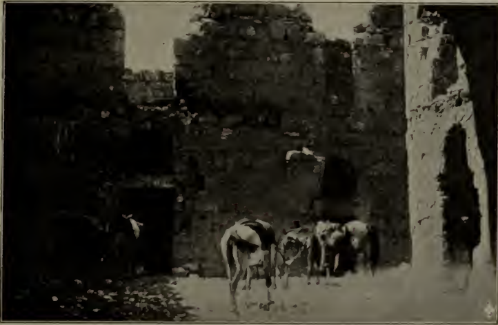
Fig. 131. Kaşr al-Ḥarāni. Der Hof von Süden.
