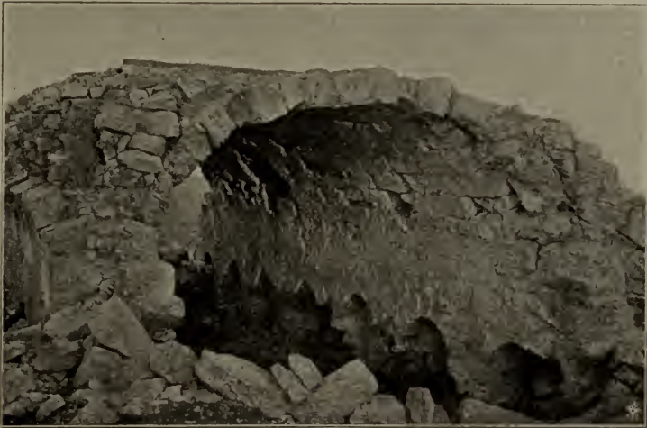
Fig. 79. Qasr al-Mwaqqar. Mittelraum der dreiteiligen Anlage von Norden.
