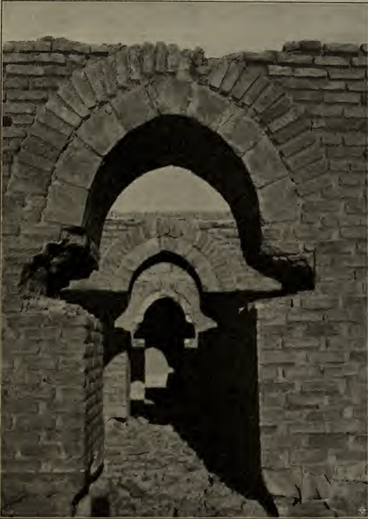
Fig. 69. Kaşr at-Tûba. Durchsicht durch die Verbindungstüren von Westen.
