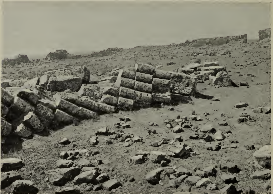
Fig. 89. Ḳaṣr al-Mšatta. Eingestürzter Pfeiler.
