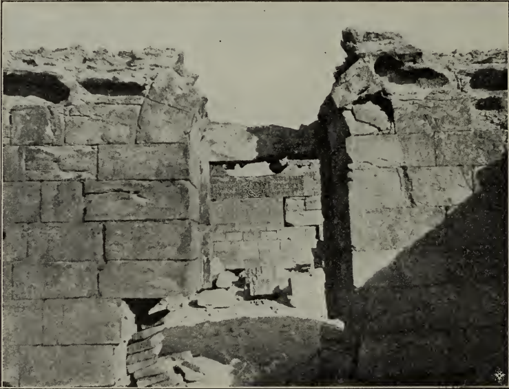
Fig. 64. Kaşr at-Tûba. Der Anbau von Osten.
