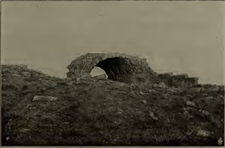
Fig. 78. Qasr al-Mwaqqar. Die dreiteilige Anlage von Norden.
