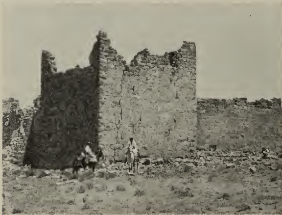
Fig. 3. Kaşr Bşejr. Der Südostturm von Südosten.
