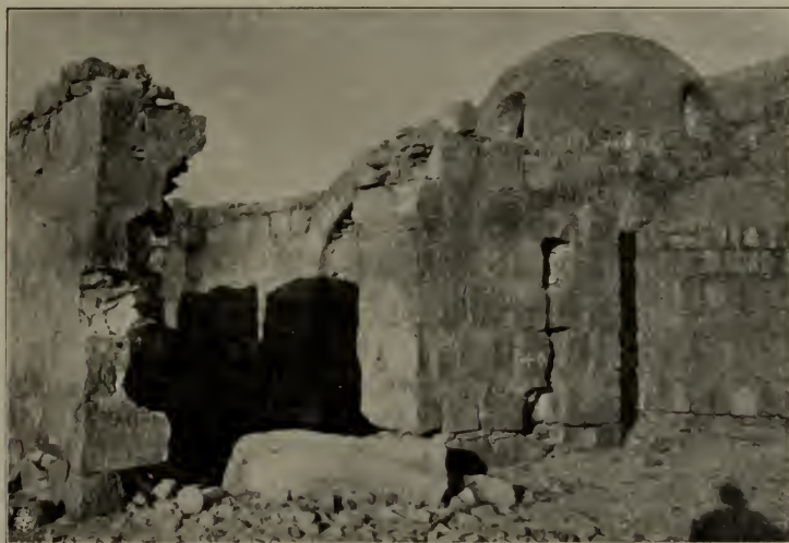
Fig. 103. Kuşejr 'Amra. Der Hofeingang von Norden.
