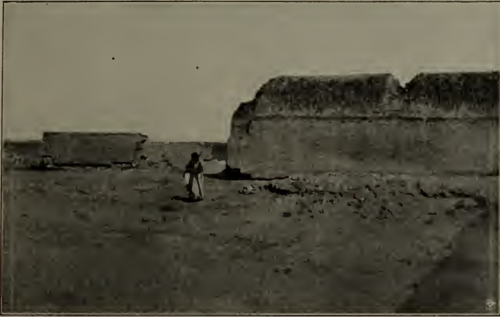
Fig. 67. Kaşr at-Ṭūba. Die nördliche Hälfte des Haupttraktes von Osten.
