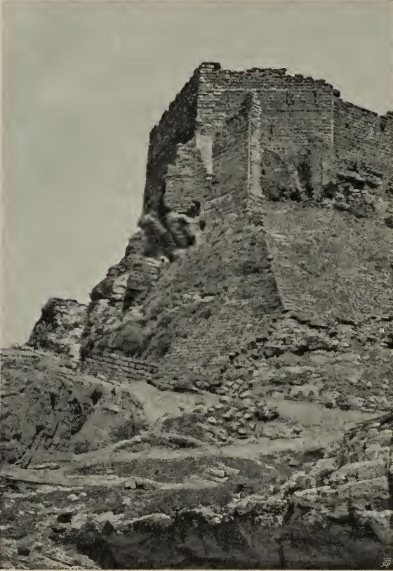
Fig. 19. El-Kerak. Die Südostecke der Festung von Osten.
