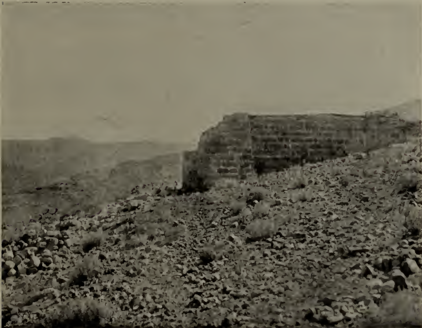
Fig. 164. Hjrbe Fênân. Der Abschluß der Wasserleitung von Südwesten.
