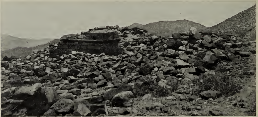
Fig. 157. Ĥirbe Fênân. Vom römischen Turme gegen Nordosten.
