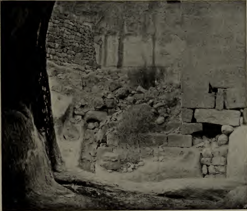
Fig. 26. Wâdi Mûsa. Al-W'ejra. Vom Tunnel gegen Westen.
