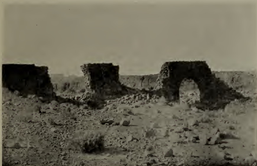
Fig. 163. Ħirbe Fênân. Die Wasserleitung von Nordosten.
