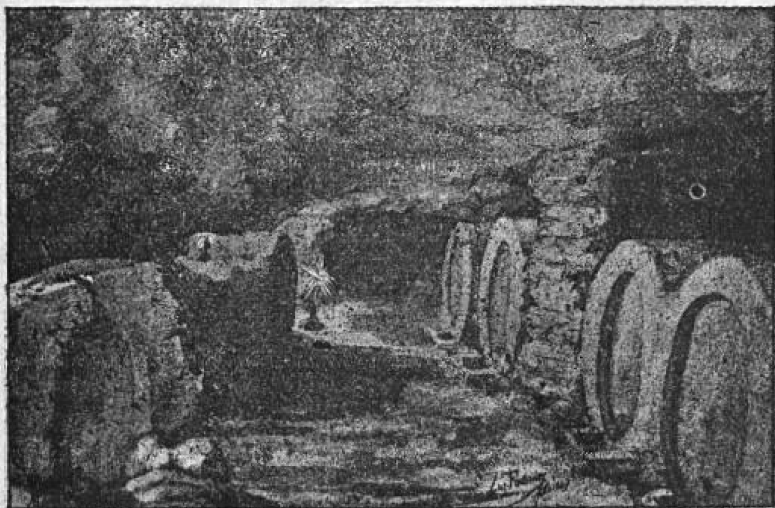
Planche II. — Galerie des tonneaux, vue de l'entrée de la cave.
