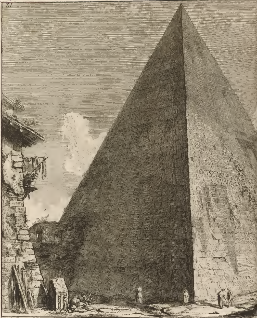
VEDUTA della Piramide di Cajo Cestio, situata sopra l'antica Via Ostiense, oggi detta di Roma, le quali sono congiunte ai lati della Piramide. Furono esse dilattate sino a questo Sp. se detta oggi di S. Paolo.
