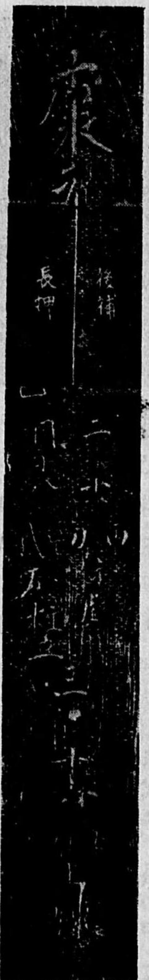
「後補」「長押」の文字の間の垂直白線は、後補長押のつき目を示す。
