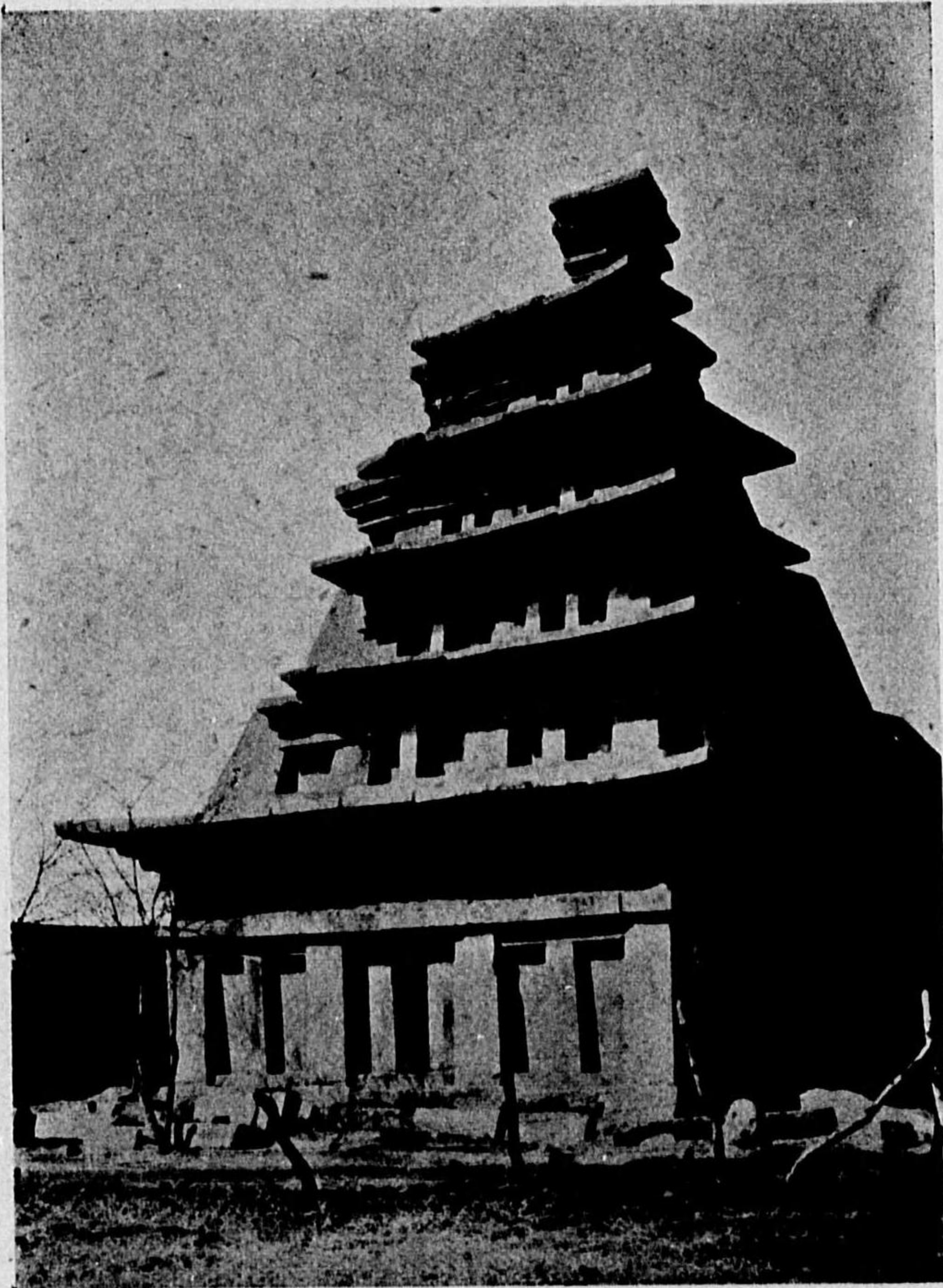
九三。彌勒塔（昭和十三年三月二十日） 彌勒塔を東南方からみたところ。圖では光線のあたってゐる方が南。各重補強の東には「大正四年」と刻してある。
