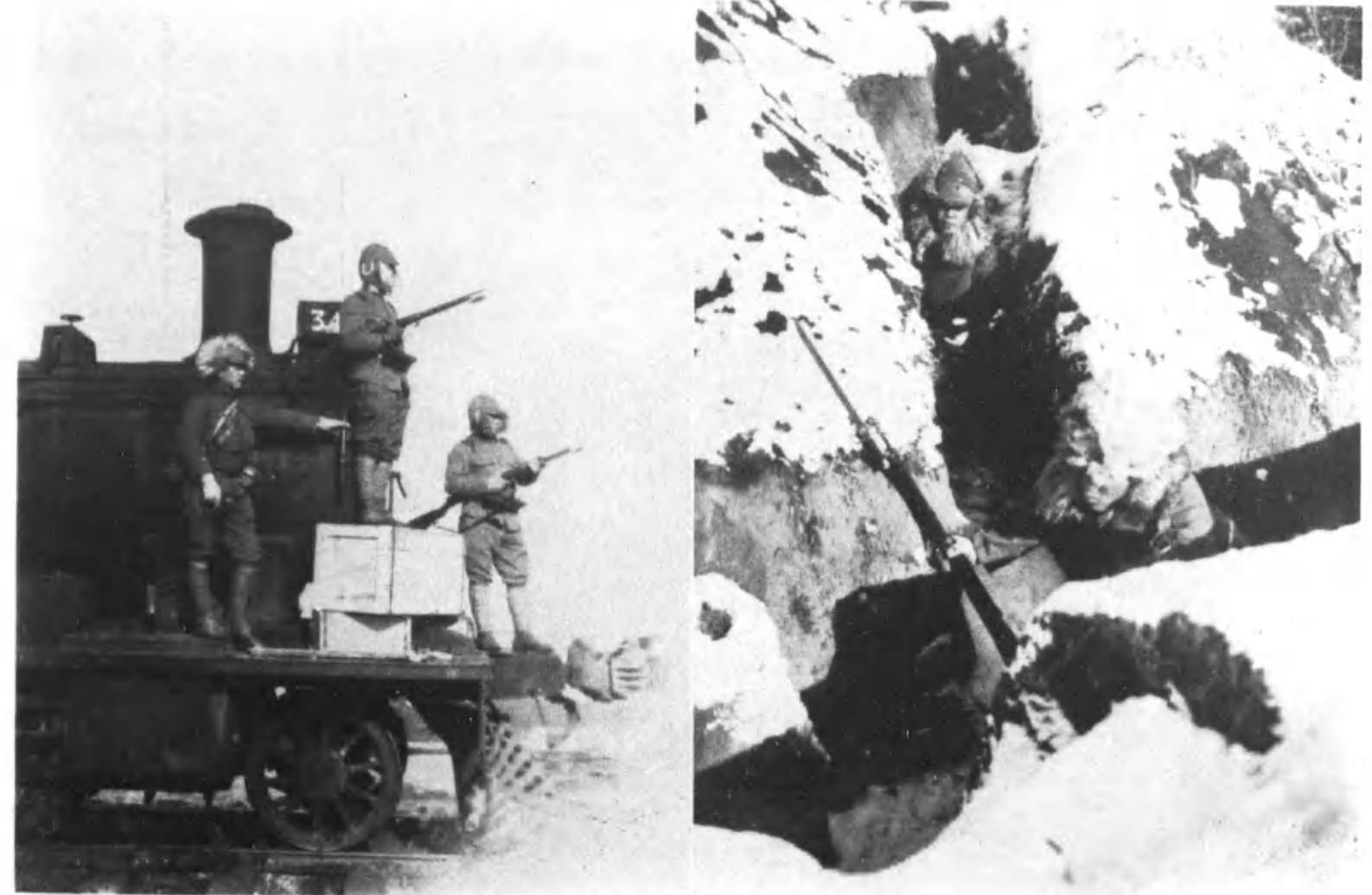
寫眞右、雪の兵營附近を守備する我兵士、寫眞左は便衣隊、別働隊の跳梁により破壊さる鐵道を警戒中の我鐵道聯隊の活躍。
