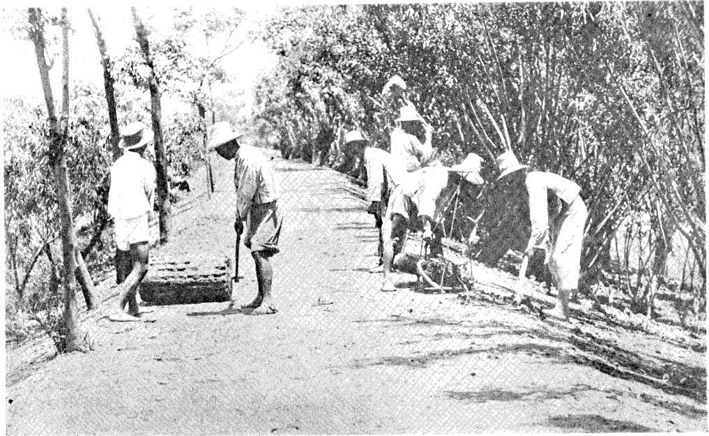
堤防修繕之一
