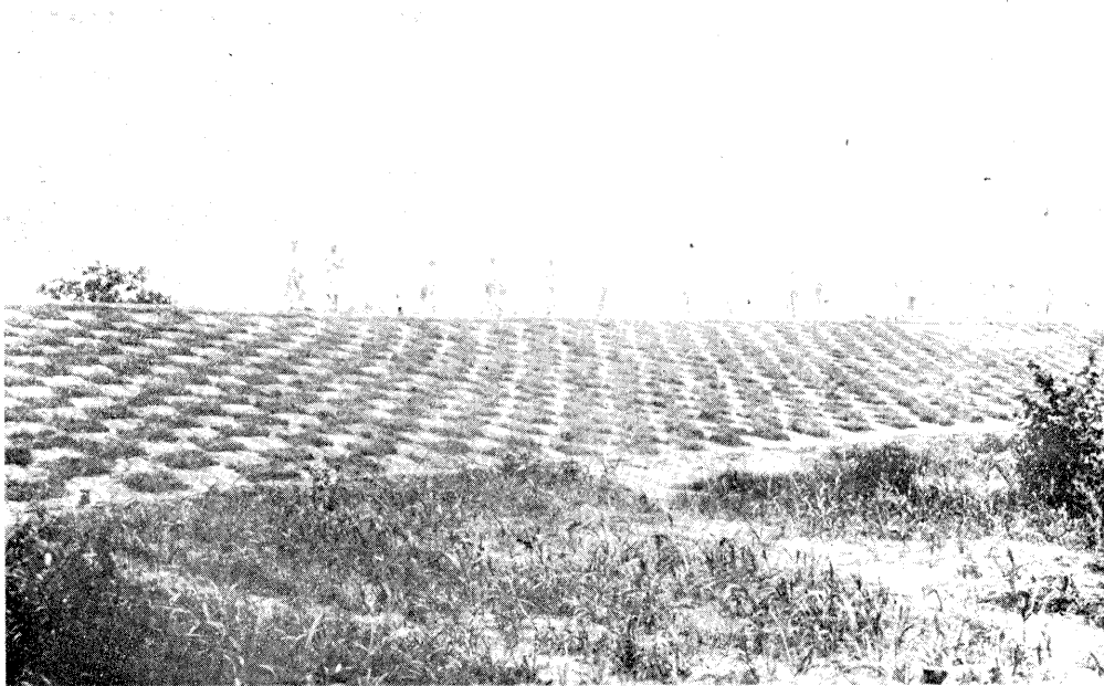
堤防覆加泥土以免浸潰情形
