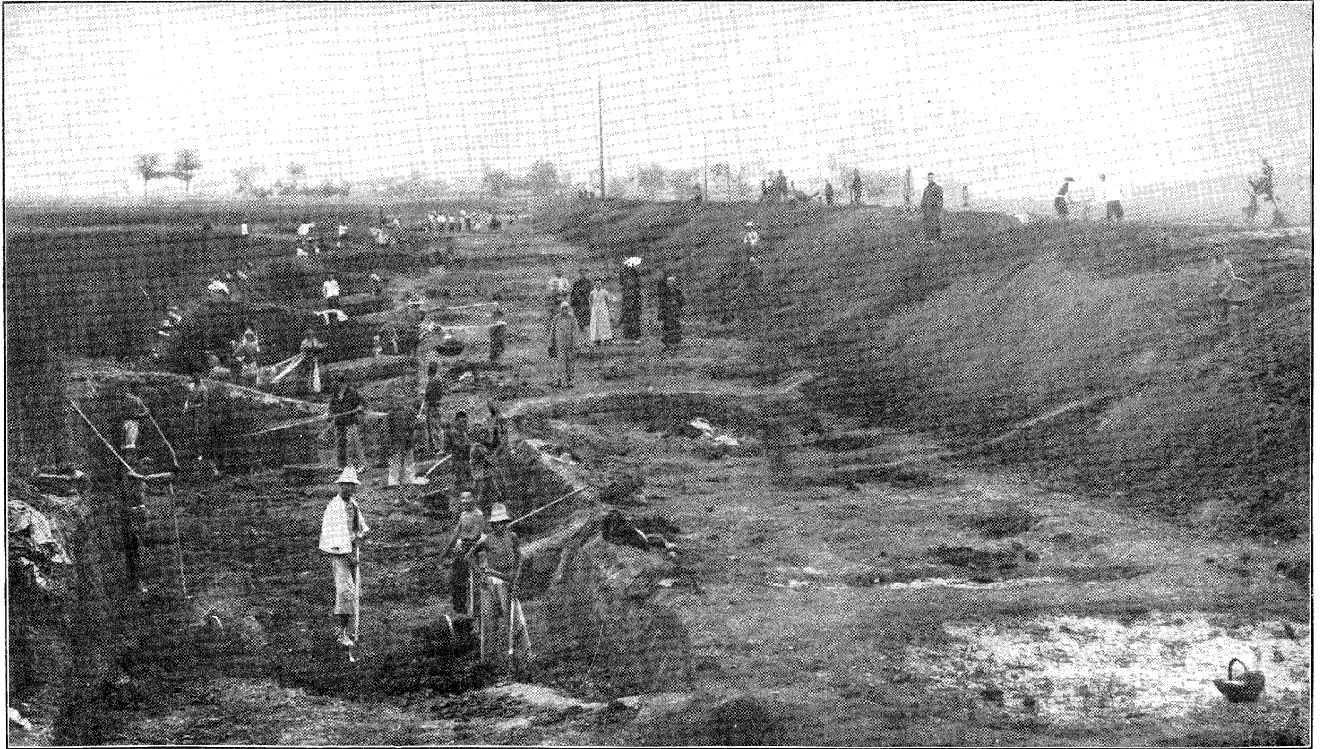
堤築土取工災
