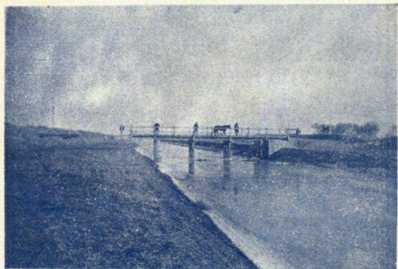
薩縣民生渠支渠橋梁
