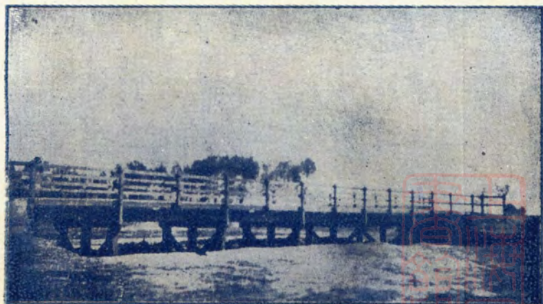
薩縣民生渠幹渠橋梁
