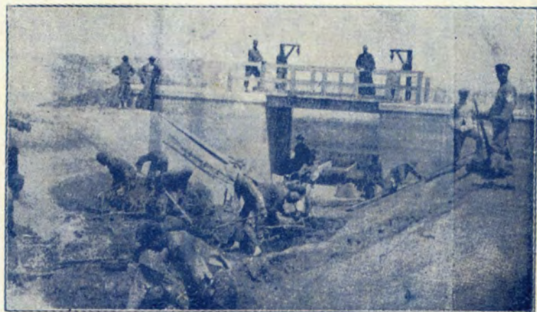
薩縣民生渠支渠閘口工作
