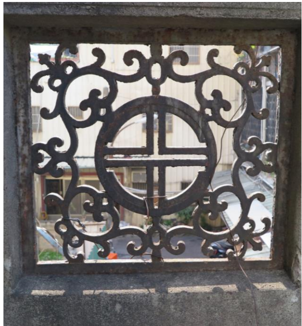
圖 2-4-17 入口處上方露台右側的鑄鐵雕花
