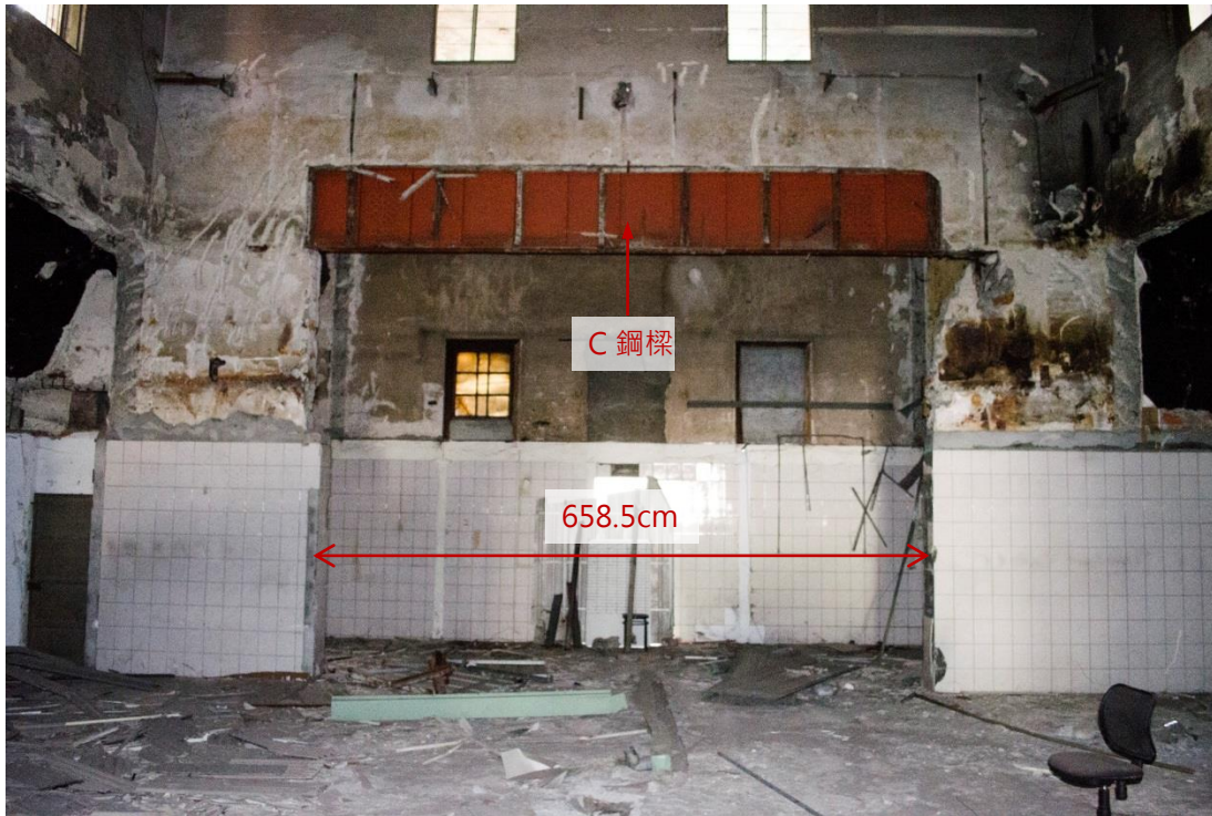
圖 3-3- 35 天外天劇場一樓後半部空間之 C 鋼樑-1 資料來源：本研究團隊拍攝。
