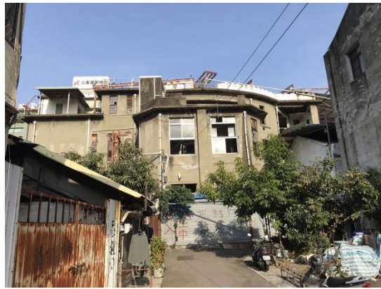
左側立面 (局部)
