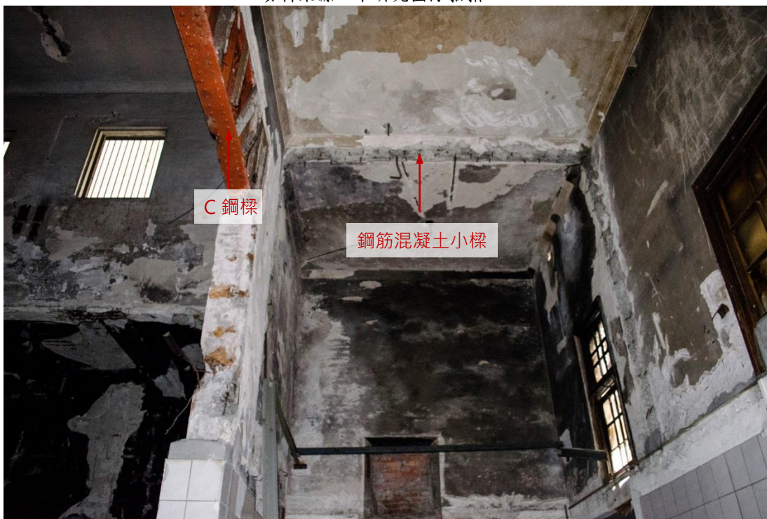
圖 3-3- 36 天外天劇場一樓後半部空間之 C 鋼樑-2 資料來源：本研究團隊拍攝。
