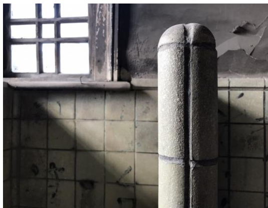
3樓廁所的手工磁磚
