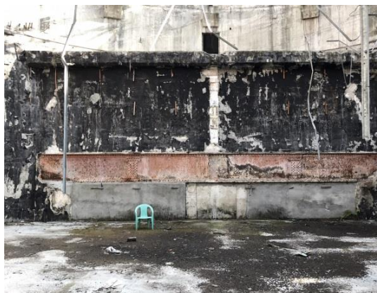
2樓增建的平台空間
