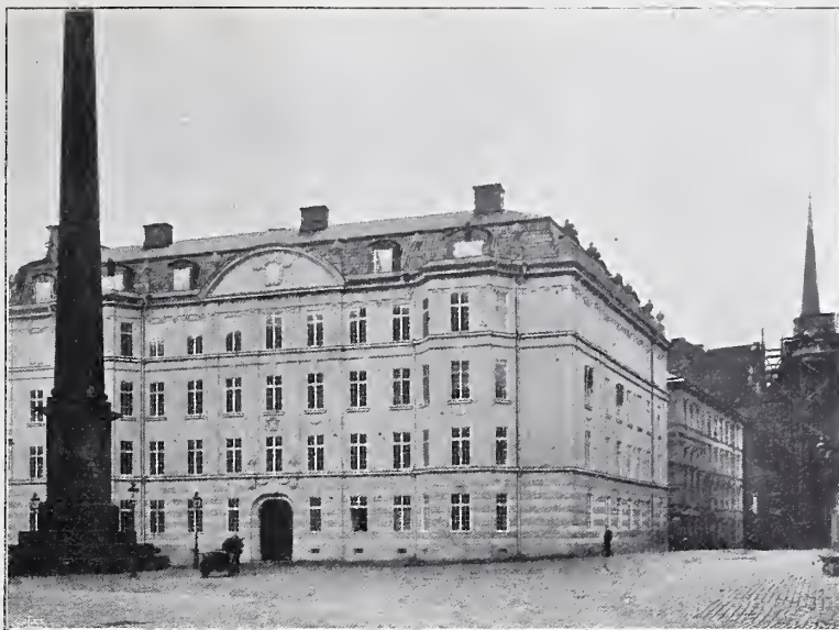
BYGGNAD FÖR HOFSTATEN, VID SLOTTSBACKEN I STOCKHOLM. ARKITEKT: ERIK JOSEPHSON.
