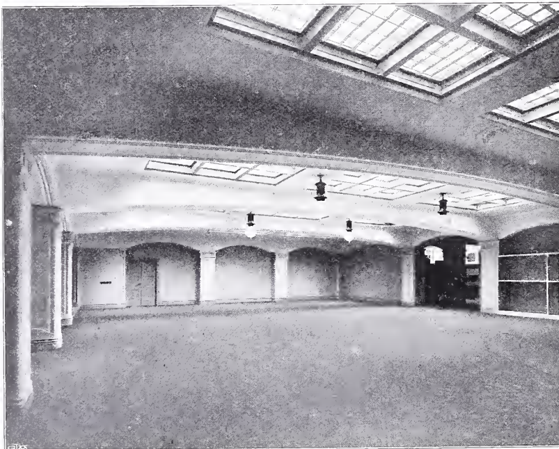
FIG. 6. KÄLLARLOKALEN UNDER UTSTÄLLNINGSHALLEN UTVISANDE DE STORA HVÄLFDA BALKARNA I TAKET.
