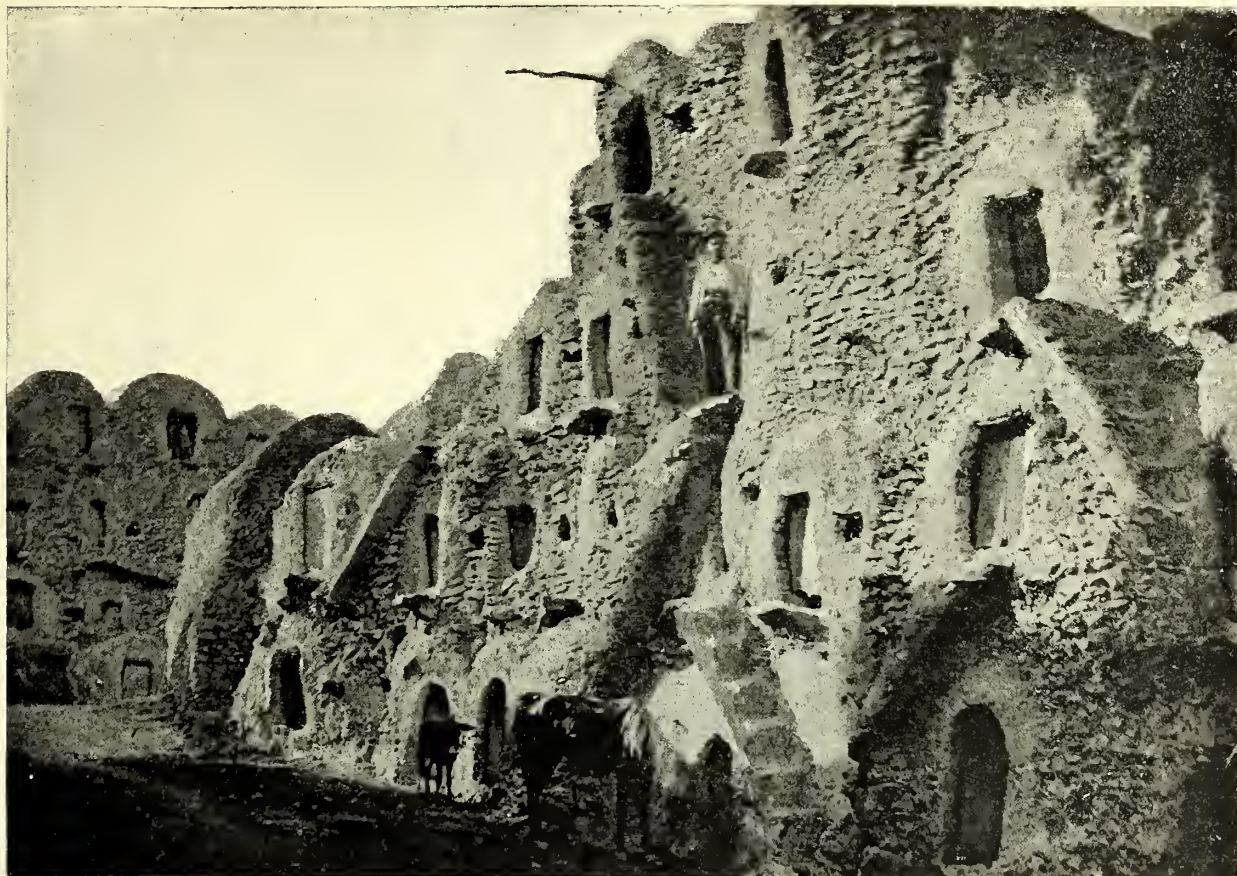
VUE INTÉRIEURE DE MÉTAMER, MONTRANT LES MAISONS EN VOUTE A PLUSIEURS ÉTAGES ET LES ESCALIERS PRIMITIFS PERMETTANT D'ACCÉDER AUX ÉTAGES SUPÉRIEURS (p. 77).
