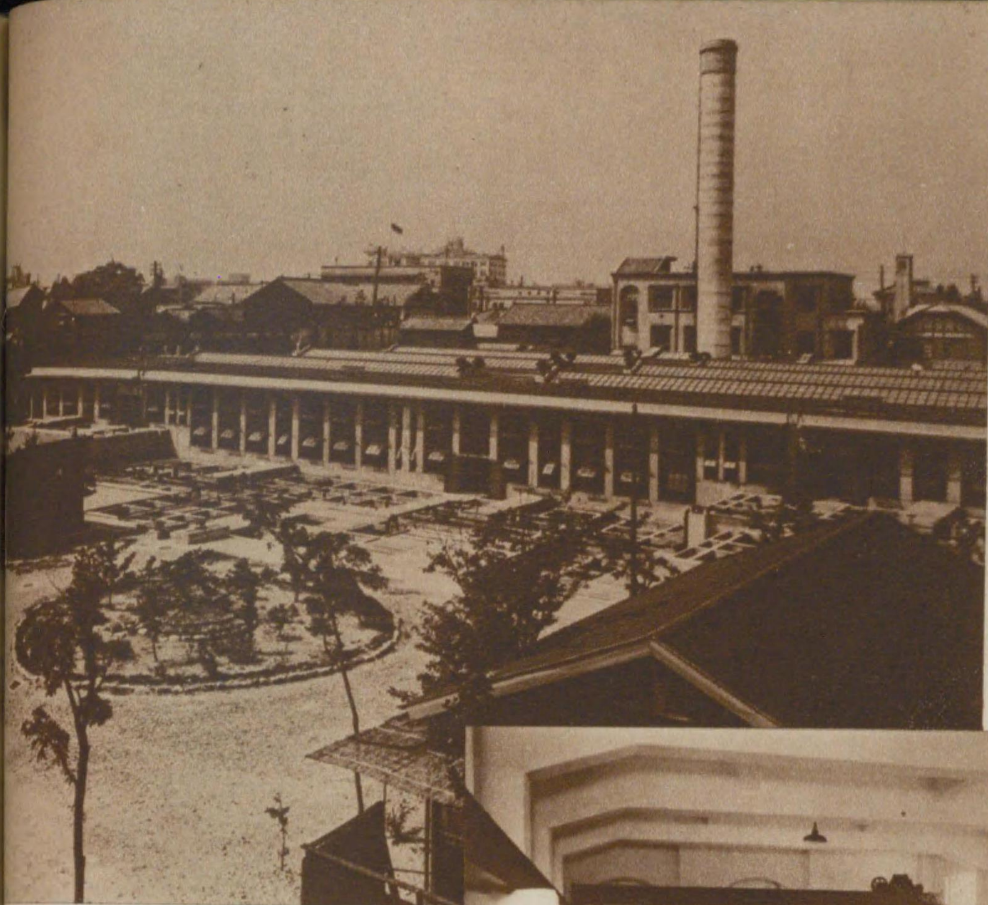
堀留下水処理場(左)と その機械室(下)
