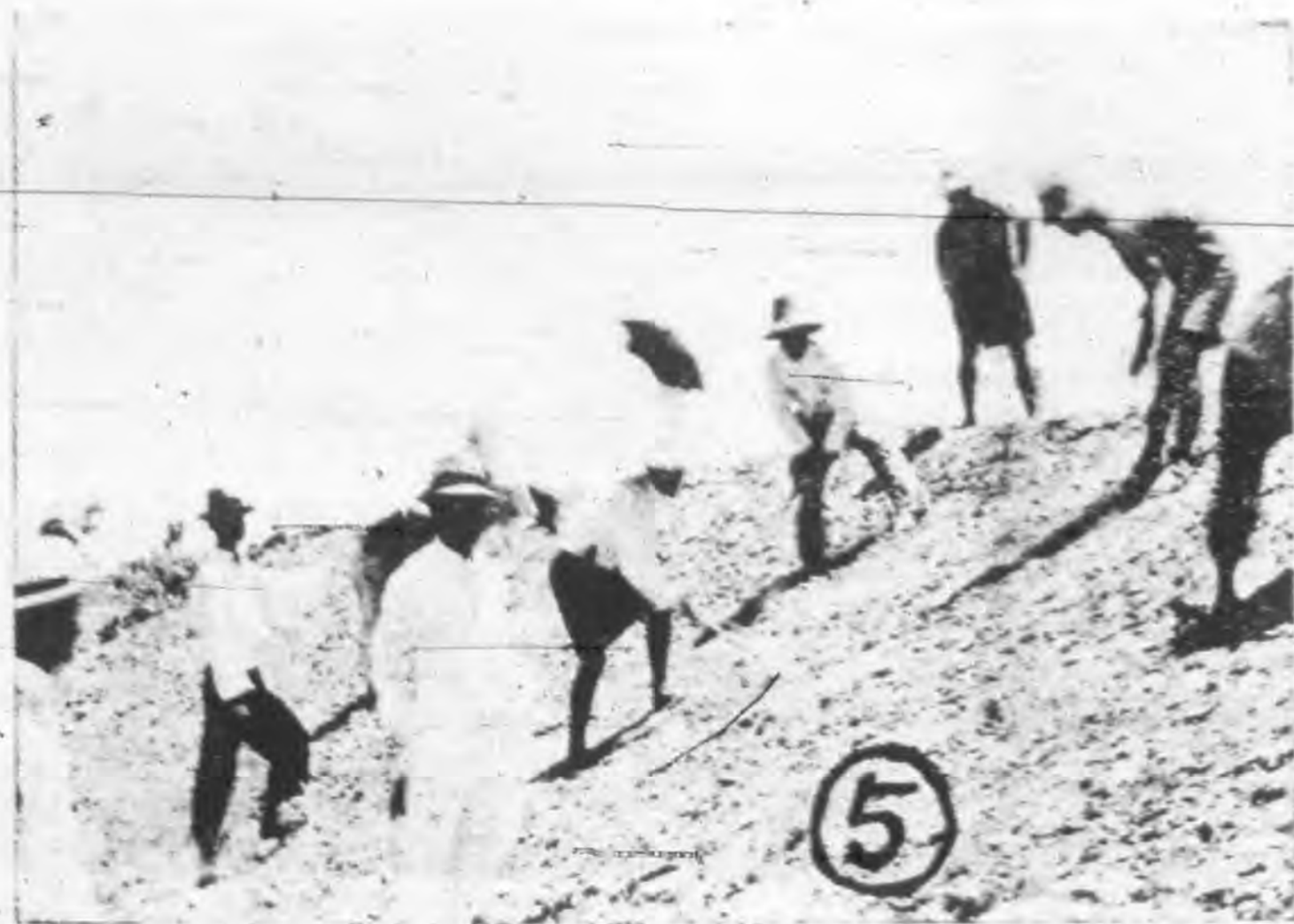
個修整江堤邊坡
