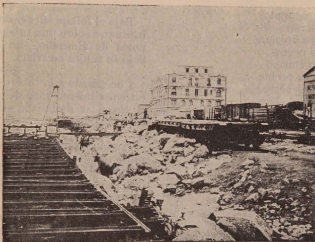
Obras del Malecon
