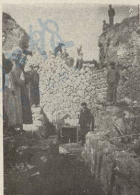
→ 拆卸城垣建築涵洞狀況
