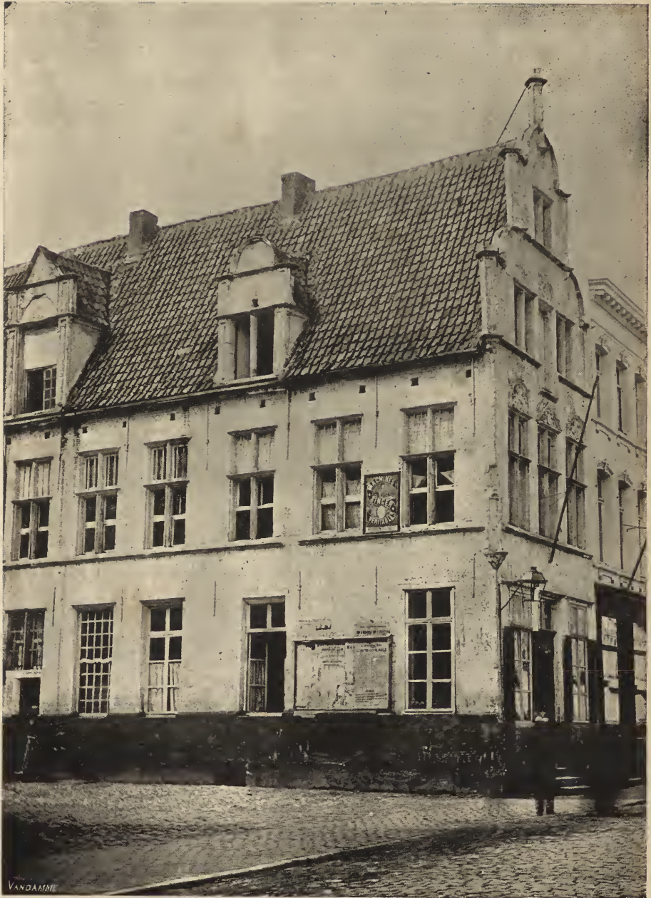
Maison rue Notre-Dame (Façade latérale)
