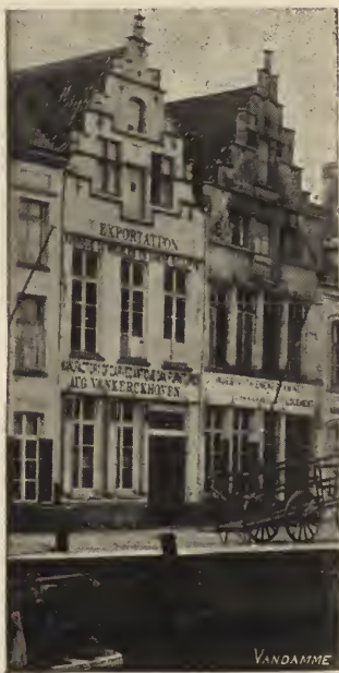
Maisons Quai au Sel
