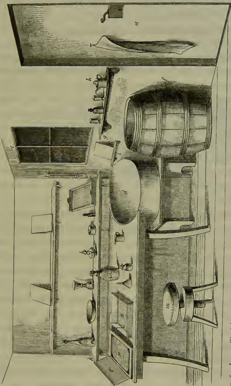
Fig. 6. Innere Einrichtung des Dunkelzimmers. *a*) Thüre. *b*) Arbeitstisch. *c*) Bänkehen, auf welchem das Abspülgefäß ruht. *d*) Abspülgefäß. *e*) Mit gelbem Papier überklebtes Fenster. *f*) Wasserbehälter. *g*) Brett über dem Wasserbehälter. *h*) Abspülkanne. *i*) Leisten zur Anstellung von Glasplatten. *k*) Brett an der Hinterwand. *l*) Thermometer. *m*) Stuhl. *n*) Aufgeschlagene Cassette. *o*) Tasse für das Silberbad.
