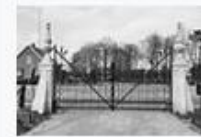
Exterieur OVERZICHT TOEGANGSCHIEK
