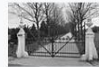
Exterieur OVERZICHT TOEGANGSCHIEK
