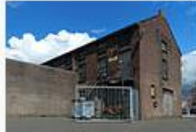
Atelier Ad Coremans van Goghstraat 25 Rijen 2.jpg 3,37 MB
