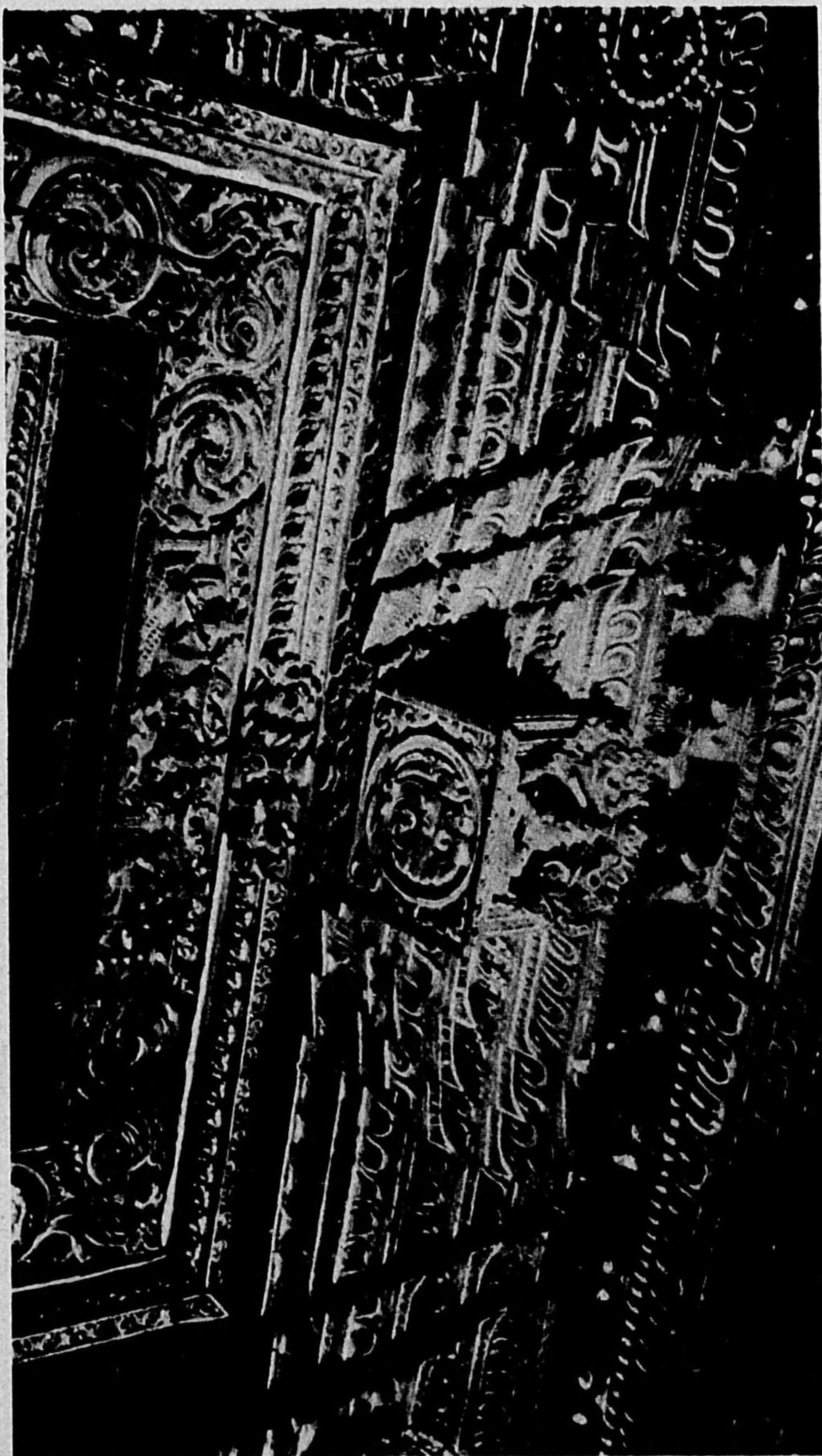
二三〇 印度教祠堂重出入口上彫刻 (昭和十一年二月十八日) 出入口や窓等は常に枠を木にて造り、それに出来得る限り精巧な彫刻を施す。全景をとるのに力を入れたので、細部はさう寫つてないから、幾多の好例を示し得ざるものであるが、まあ申議にこれをだしておく。此は二二五、二二六に掲げたマハ・デバ堂初重出入口の上の一例である。
