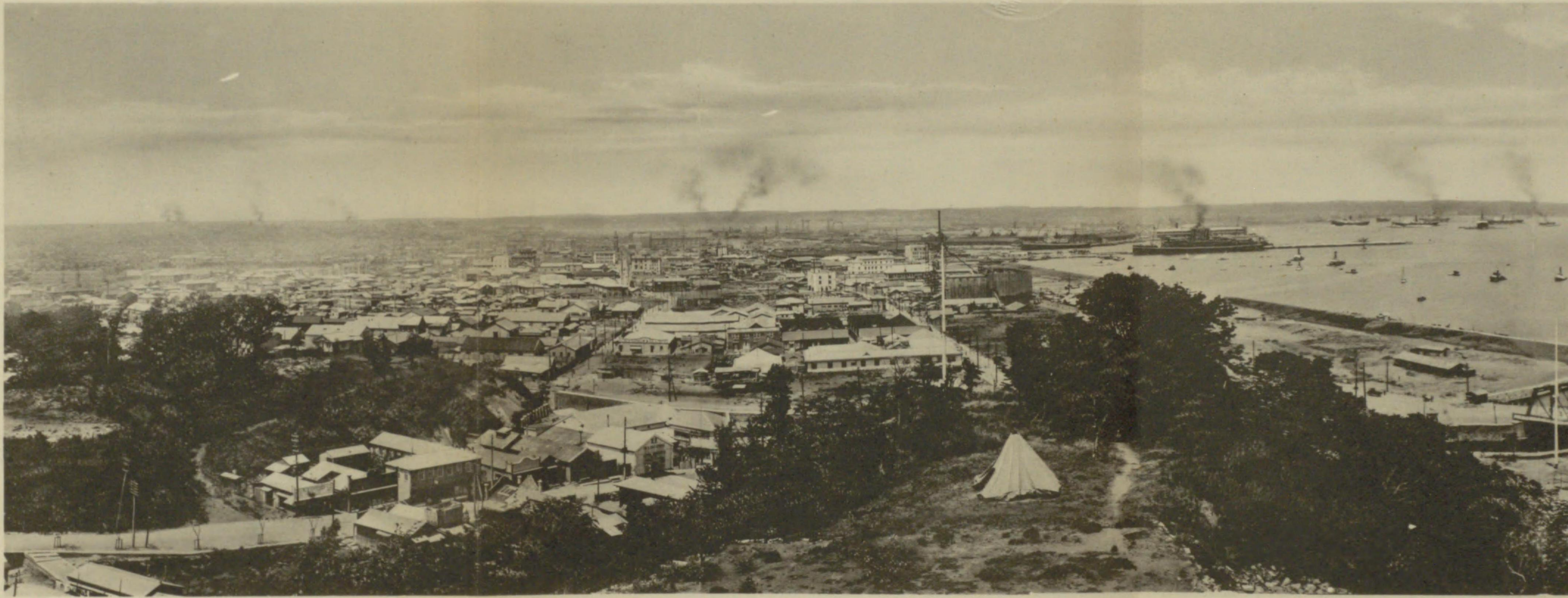
船泊所よりの内港を望む(昭和二年五月撮影)
