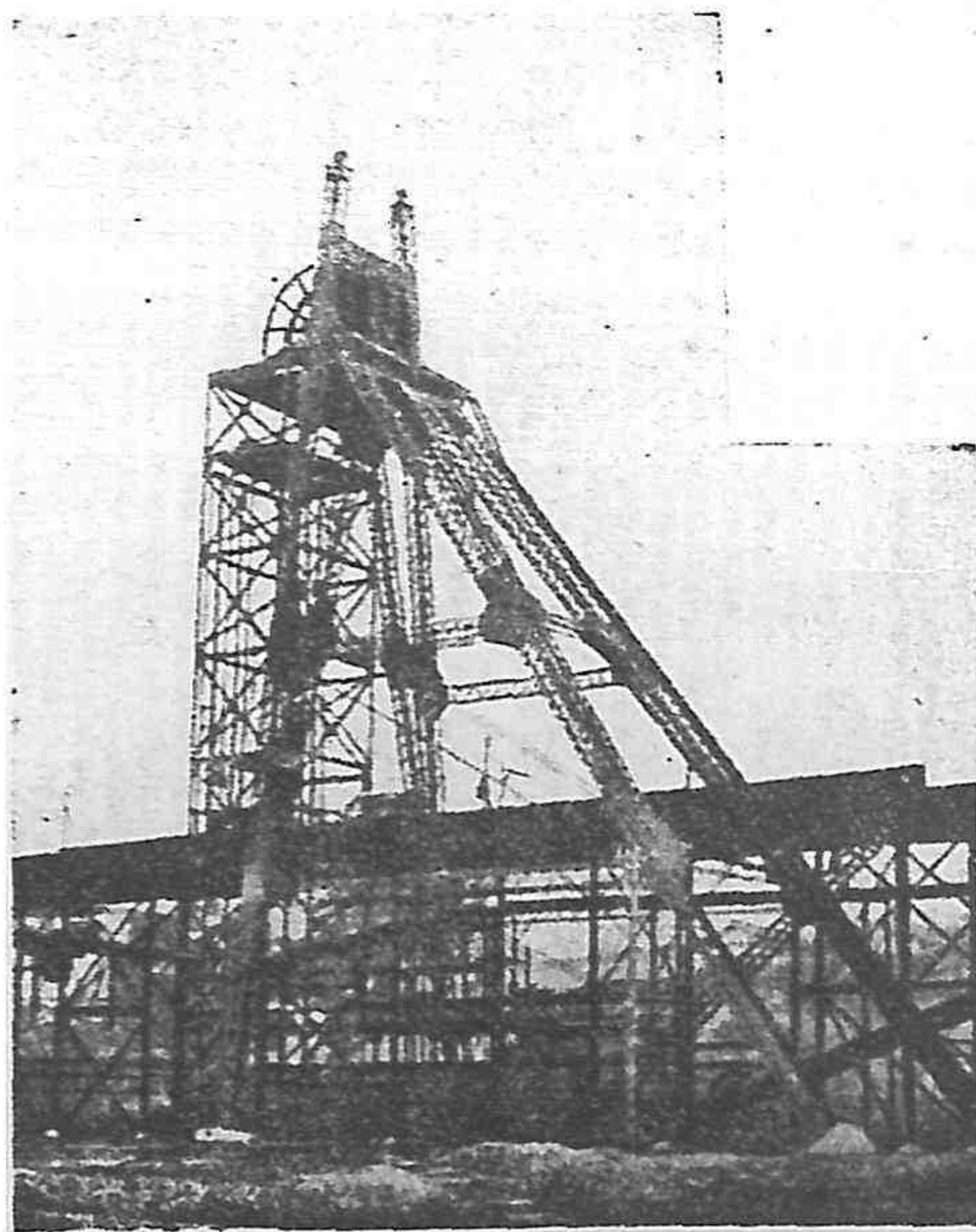
圖 23 三瀨石炭鑛山中央豎坑頂部之捲揚槽
