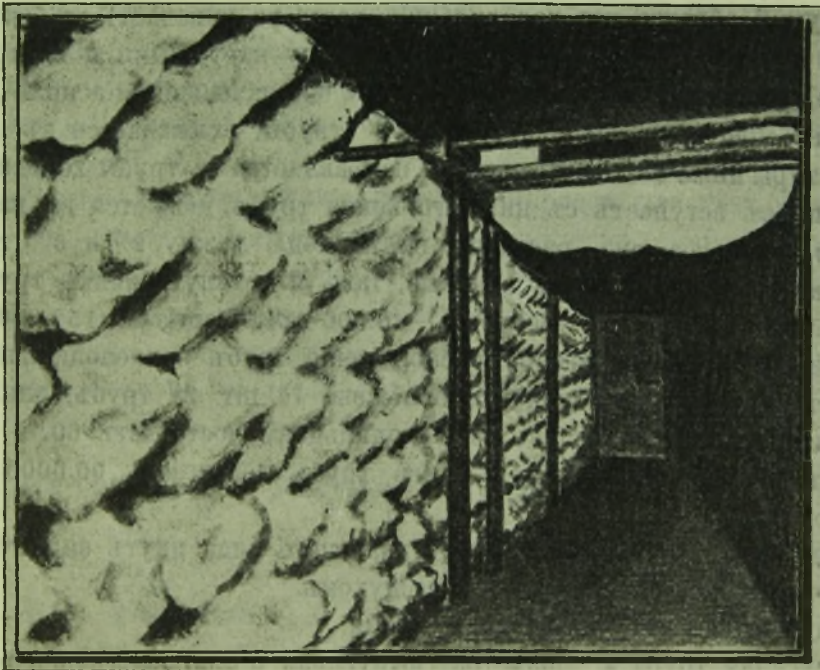
Камера холодильника съ промерзнувшими трубами.
