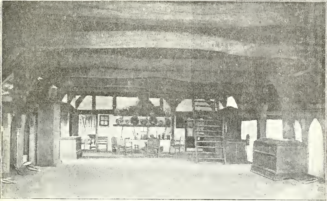
Fig. 82. — Intérieur d'une construction rurale à Østfeld, vue prise de la partie consacrée à l'étable.
