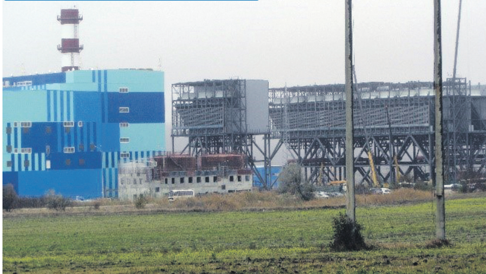
Будівництво Сімферопольської ТЕС (жовтень 2017 р.)
