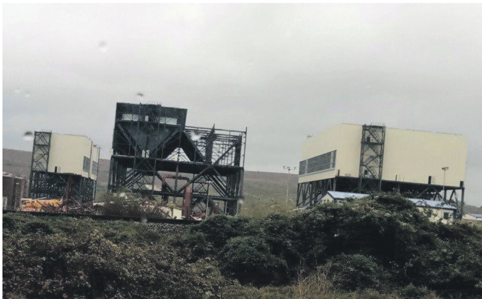
Будівництво Севастопольської ТЕС (жовтень 2017 р.)
