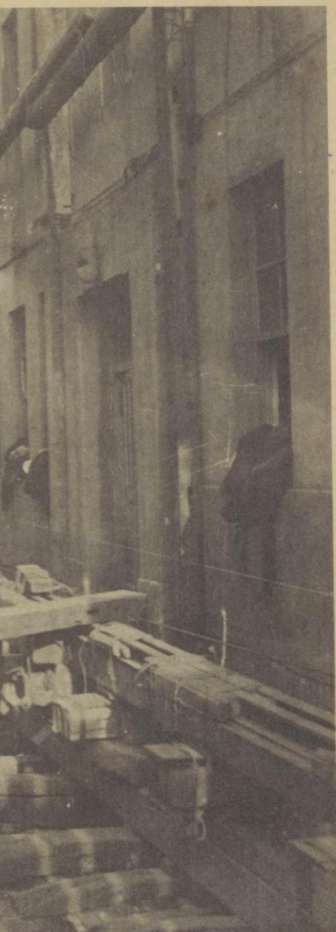
↑ 曳方移轉工事中の鐵筋コンクリート造三階建
