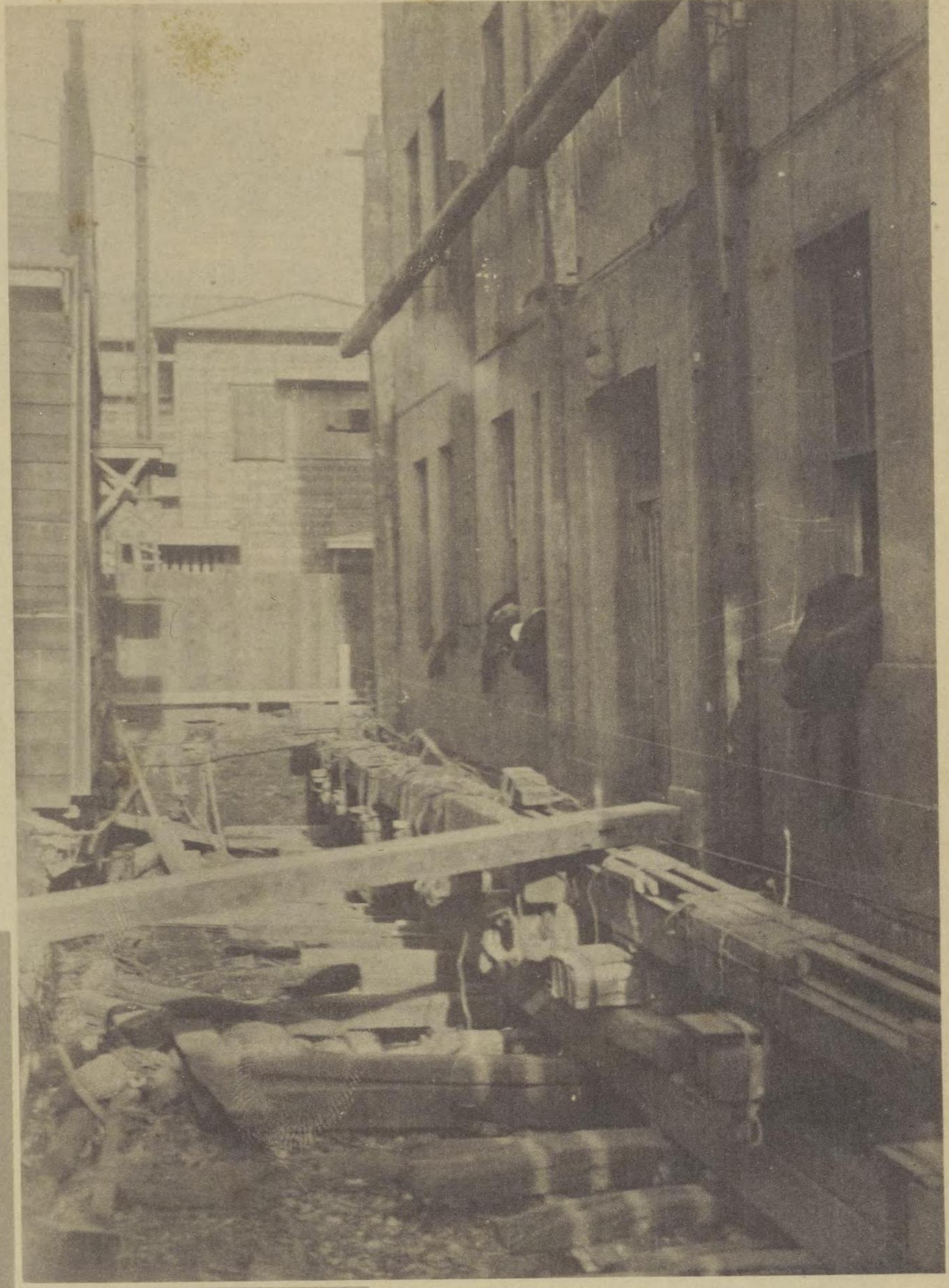
↑ 曳方移轉工事中の鉄筋コンクリート造三階建 ← 曳方移轉工事中の銅像
