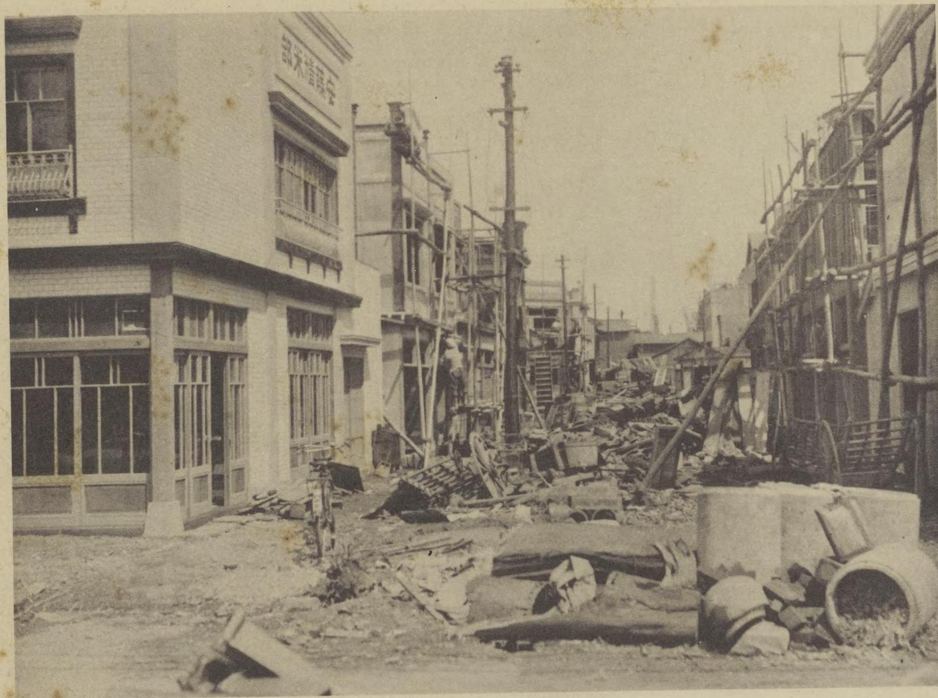
(目丁二町宕愛區芝) 況狀事工轉移の上路街設新
