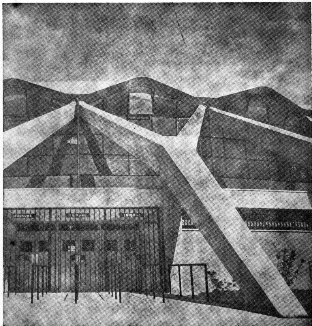
照片：在罗马的奥林匹克体育宫（小馆）支柱的细部[41] 工程师：奈尔维
