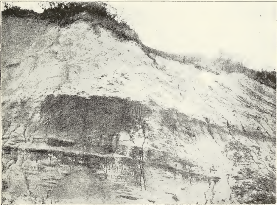
Bild 14. Austritt des Sickerwassers auf einer weniger durchlässigen tonigen Schicht in der Mitte des Gehänges. Die Durchfeuchtung ist an der dunkeln Färbung am Gehänge zu erkennen. Nordende des Marscheiter Amtswinkels. Aufgen. am 16. X. 1910.
