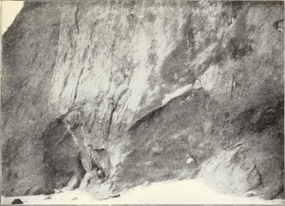
Bild 13. Unterwaschung des Basis der Geschiebemergelwand bei Kreislacken. Aufgen. am 16. X. 1910.
