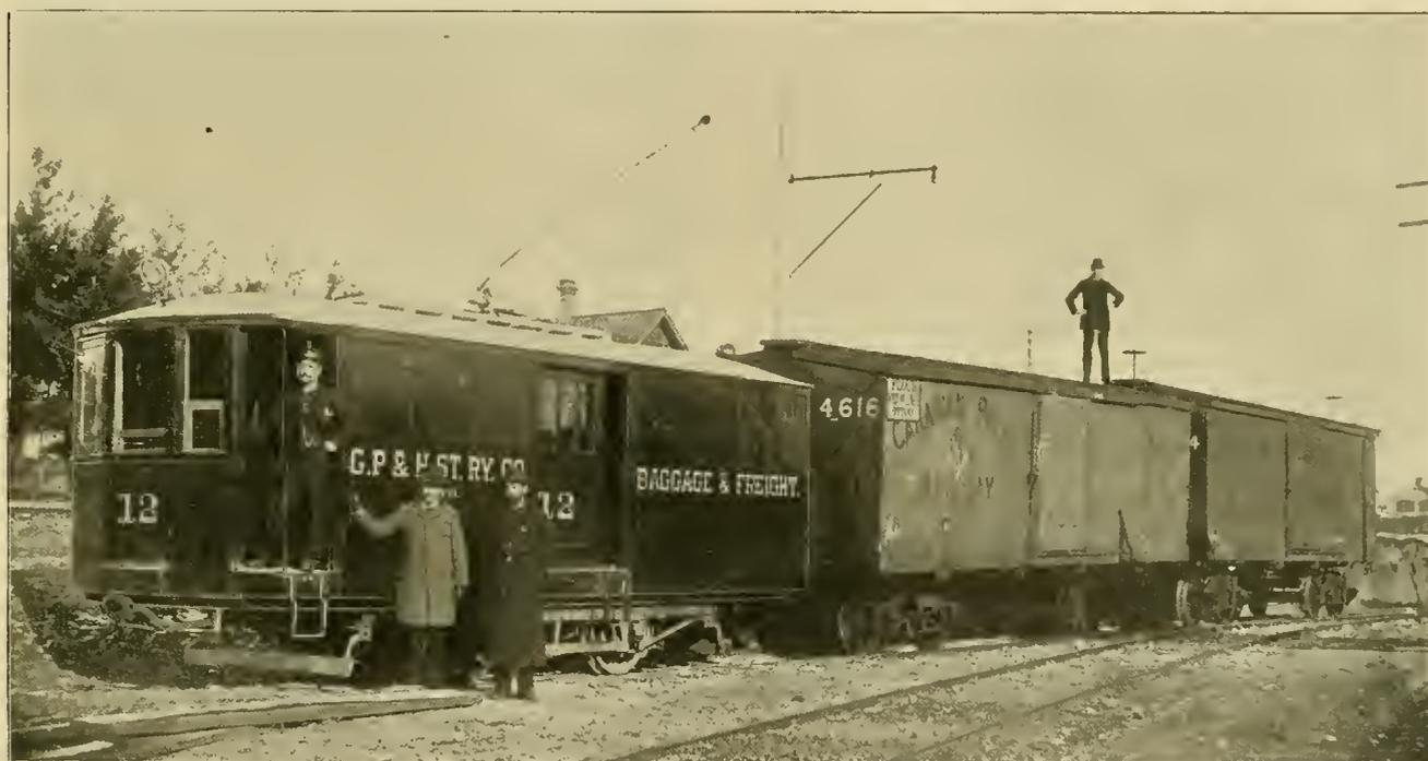
COMBINATION MOTOR AND BAGGAGE CAR WITH ITS TRAILERS.
