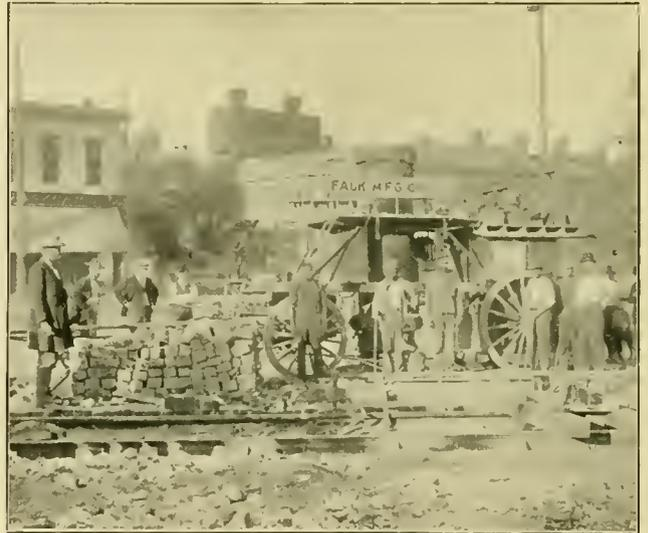
PORTABLE CUPOLA FOR CASTING JOINTS.
