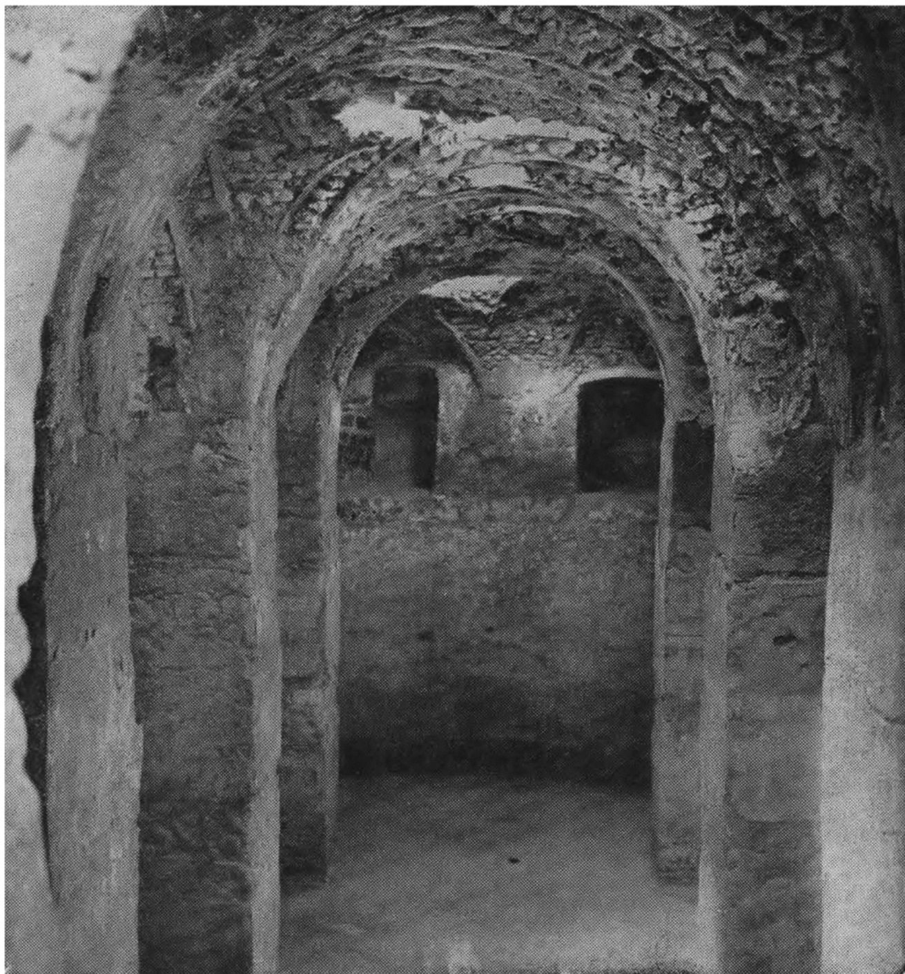
آب‌انبار قلعه پرتغالی‌ها در هرمز - روسازی مخزن مربوط بدوره تیموریان است که توسط پرتغالیها ، باشیوه معماری رومی تجدید بنا شده‌است .
