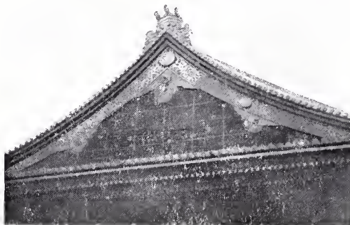
KIOTO — TETTO DI UN TEMPIO.
