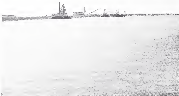
DRAGHE CHE LAVORANO ALLA COSTRUZIONE DELLA VIA IN ACQUE BASSE.
