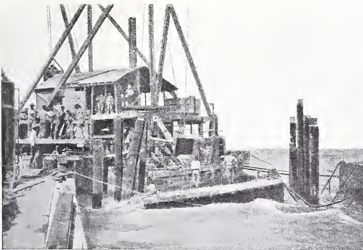
POSA DEL CALCESTRUZZO MEDIANTE PONTONE GALLEGGIANTE.
