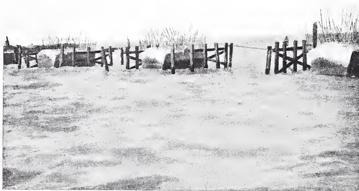
PILE PER IL VIADOTTO DI LONG KEY.
