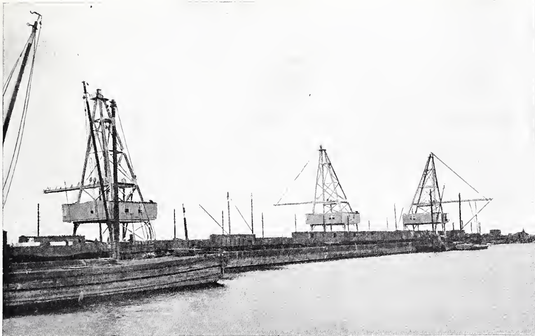
GRU ELETTRICHE DA CARICO A GREENVILLE (N. J.).
