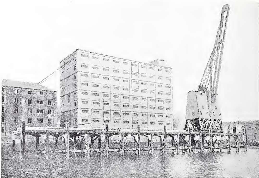
MAGAZZINI IN CEMENTO ARMATO A WATERFORD CON ELEVATORE ELETTRICO CAPACE DI SCARICARE 400 TONN. ALL'ORA.
