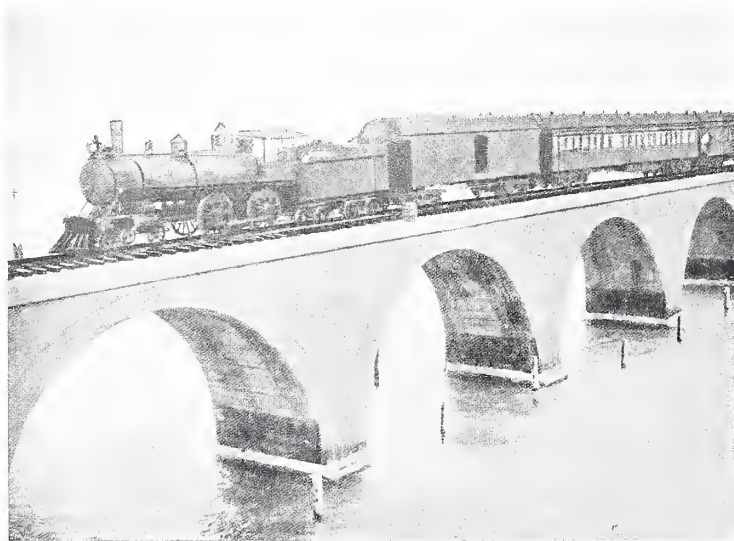
IL VIADOTTO ULTIMATO.
