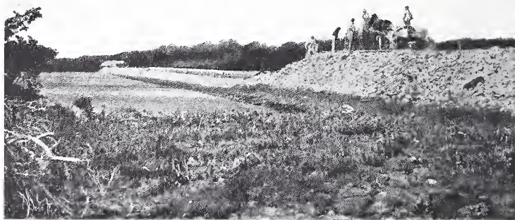
FORMAZIONE DI UN RILEVATO IN PIETRISCO.
