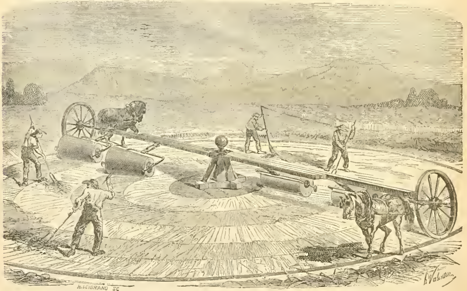
Fig. 82. — Rouleaux à manège pour l'égrenage des céréales (S. Villalongue).
