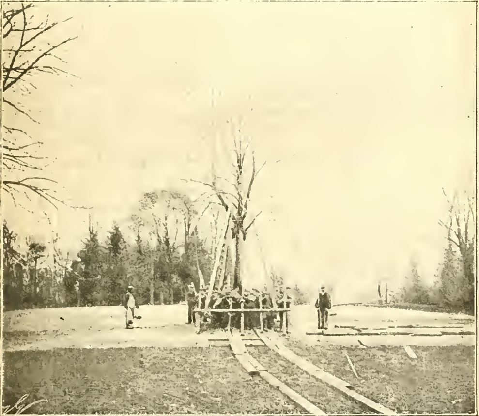
Fig. 77. — Transplantation des gros arbres; cadre avec ses rouleaux.
