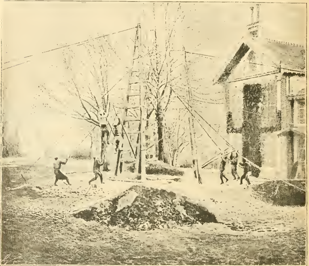
Fig. 76. — Transplantation des gros arbres ; manœuvre de l'élévation de l'arbre, par la traction sur les treuils de chèvres de charpentier.
