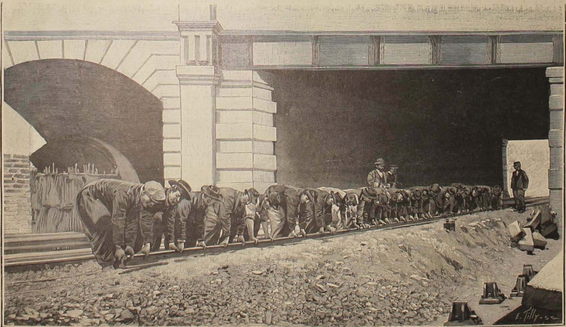
Pose d'un rail de 18 mètres : deuxième temps.
