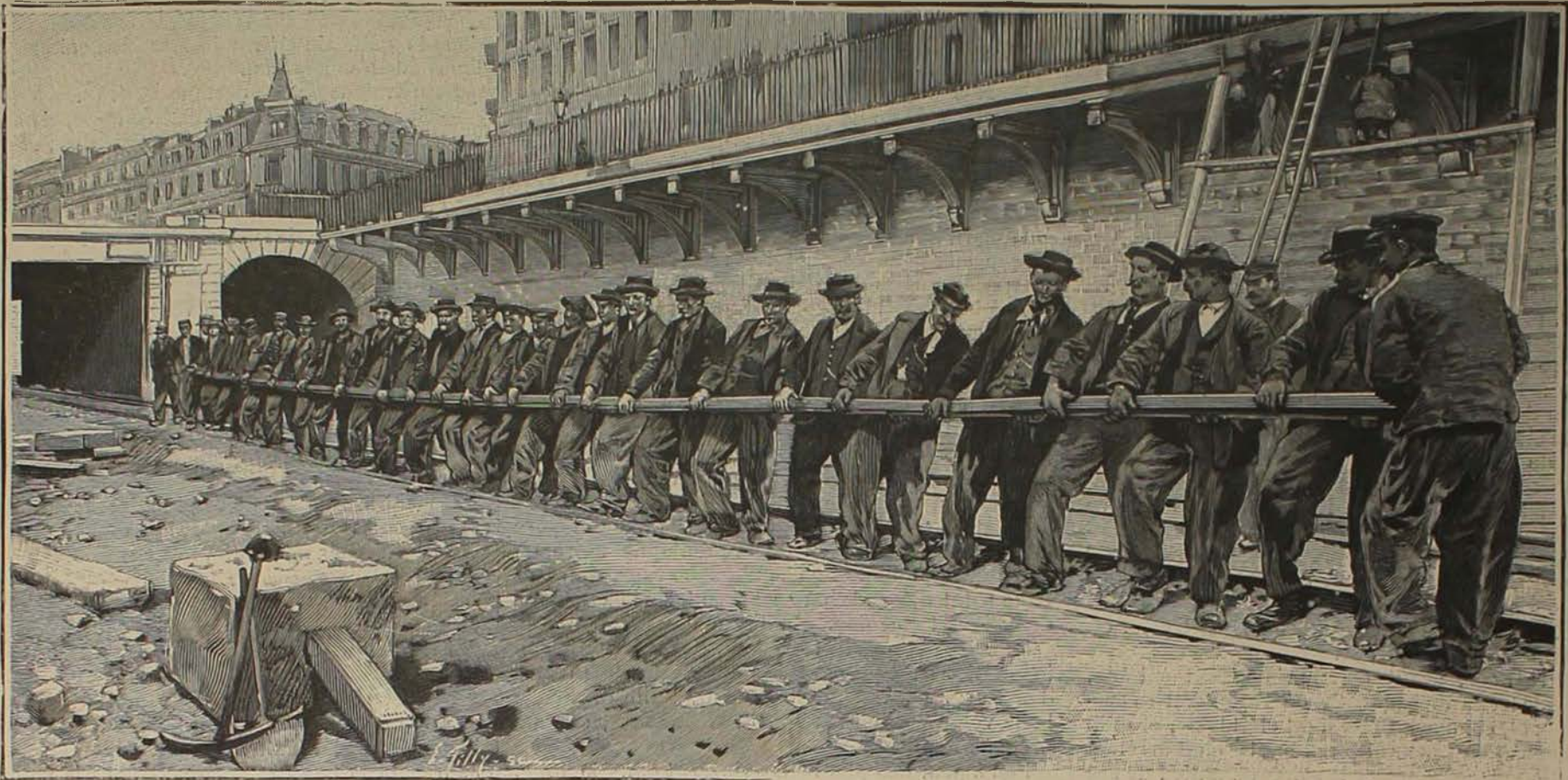
Pose d'un rail de 18 metres sur la ligne de Courcelles au Champ-de-Mars : premier temps.
