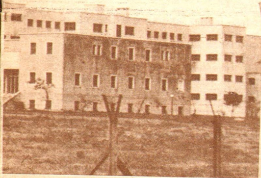
El Hospital de Llanura, producto de la obra justicialista, levanta sus modernas líneas en Villaguay.
